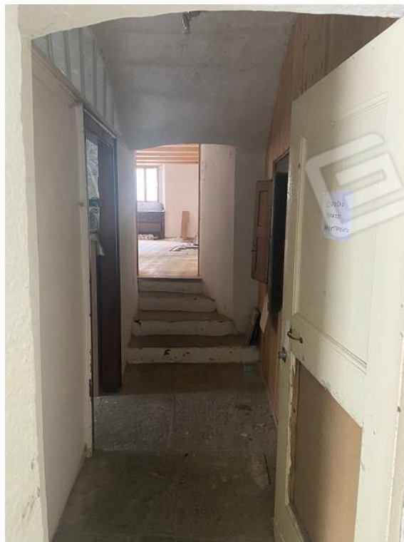
Foto 7: Ingresso alla prima parte di appartamento.
