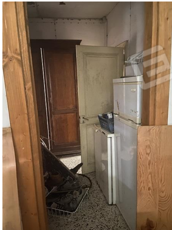
Foto 21: Seconda parte di appartamento – Camera sul fronte.
