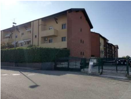
Vista ingresso carraio dal civico 10
