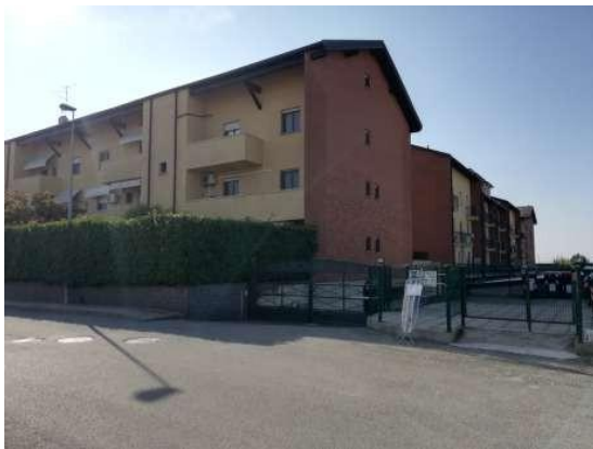
Vista ingresso carraio dal civico 10
