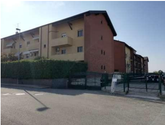
Vista ingresso carraio dal civico 10
