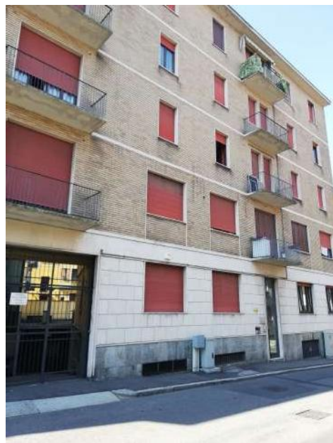
Ingresso da Via Carducci n°. 1
