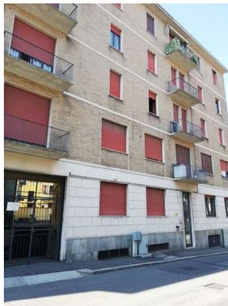
Ingresso da Via Carducci n°. 1
