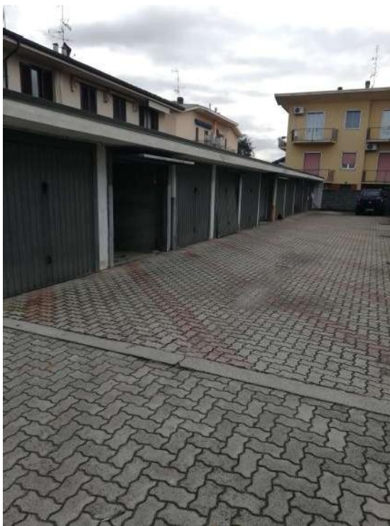
Vista generale corsia di manovra
