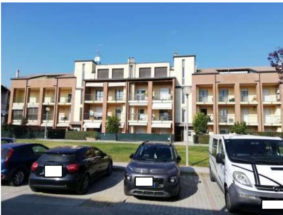
Vista ingresso pedonale da Via L. Isabella 18
