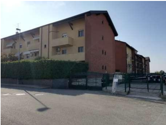
Vista ingresso carraio dal civico 10
