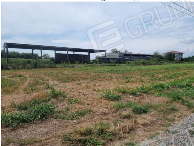
FOTO 8 – Terreno Foglio 38 mappale 152
