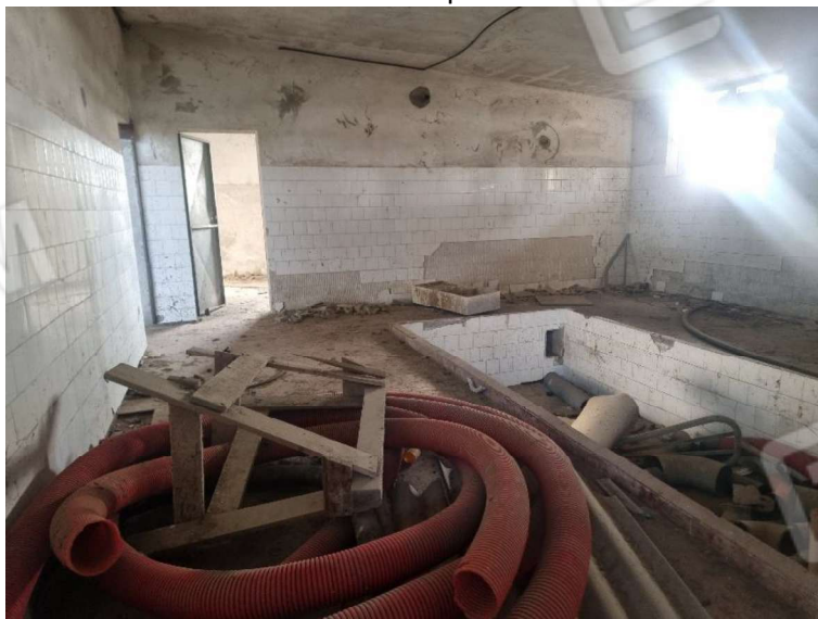
FOTO 18 – Locali accessori capannone
