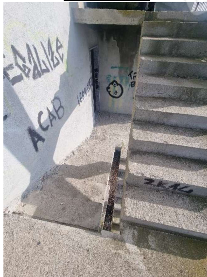
FOTO 9 – Scala di collegamento tra piano primo e piano secondo
