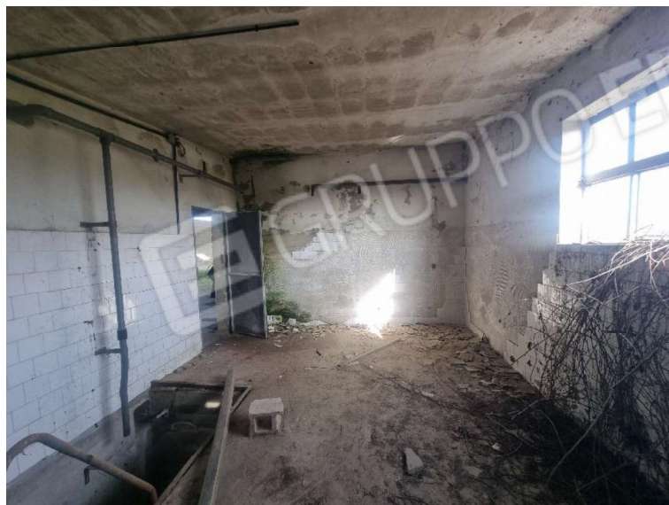
FOTO 19 – Locali accessori capannone
