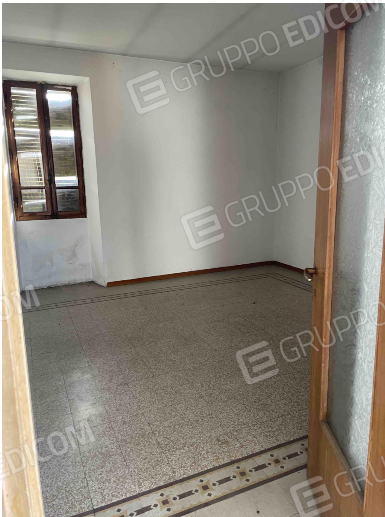
CAMERA PIANO PRIMO
