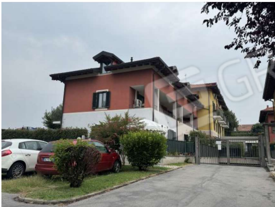
Vista Residenza Montaccio 1, blocco A da via Cosio
