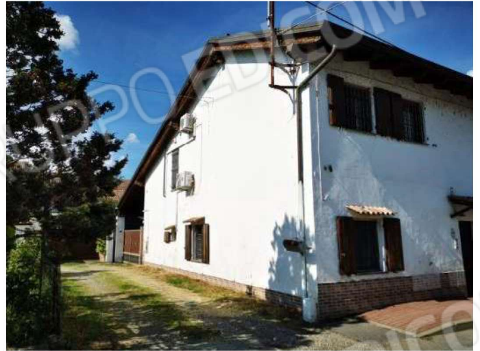
Fronte ovest e viabilità privata
