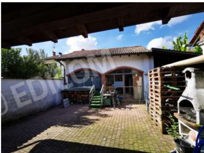
Locale di sgombero fronte sud - corte pertinenziale
