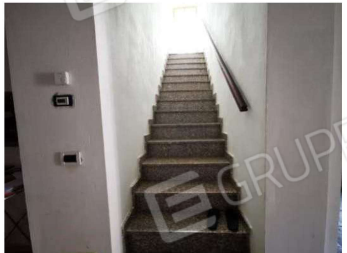
Piano terra - vano scala
