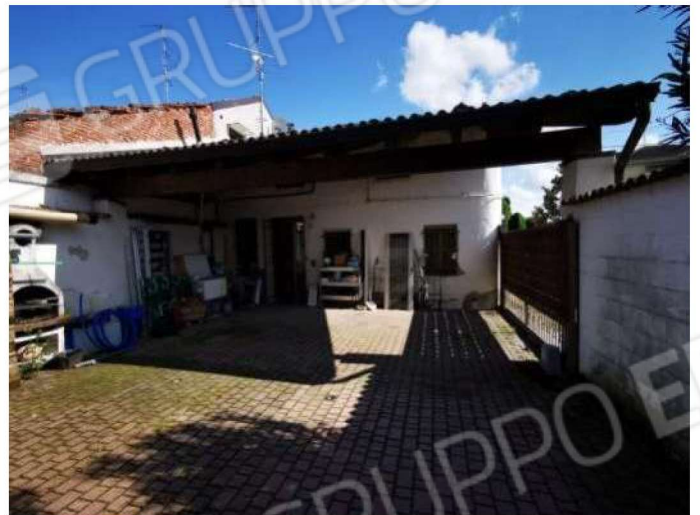
Fronte nord - portico
