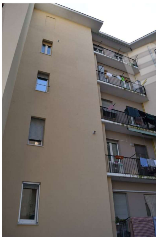
Foto 7: Prospetto su cortile interno
