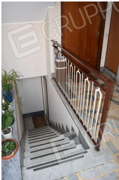
Foto 34: Cantina, vista scala d'accesso
