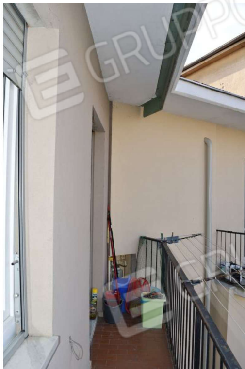
Foto 22: Balcone ad uso esclusivo del cucinino
