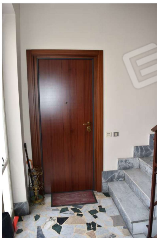
Foto 13: Pianerottolo del quarto piano e porta d'accesso appartamento
