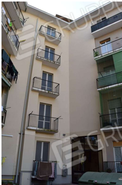
Foto 6: Prospetto su cortile interno
