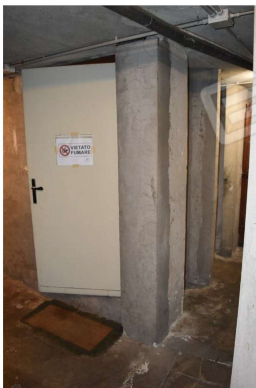
Foto 35: Cantina, vista del disimpegno comune
