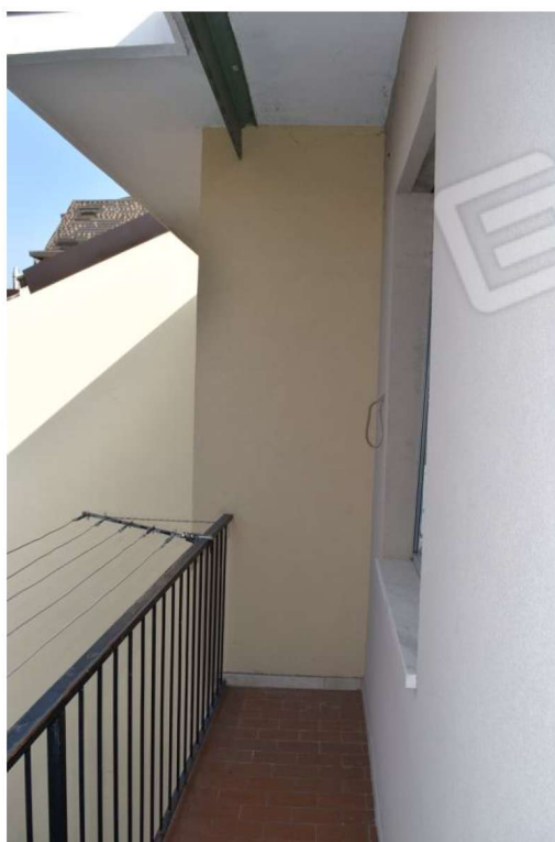
Foto 23: Balcone ad uso esclusivo del cucinino
