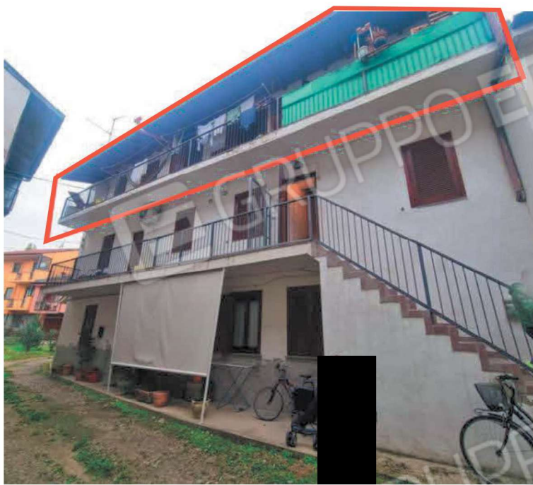
Foto 1 – Vista esterna su cortile – Prospetto sud
