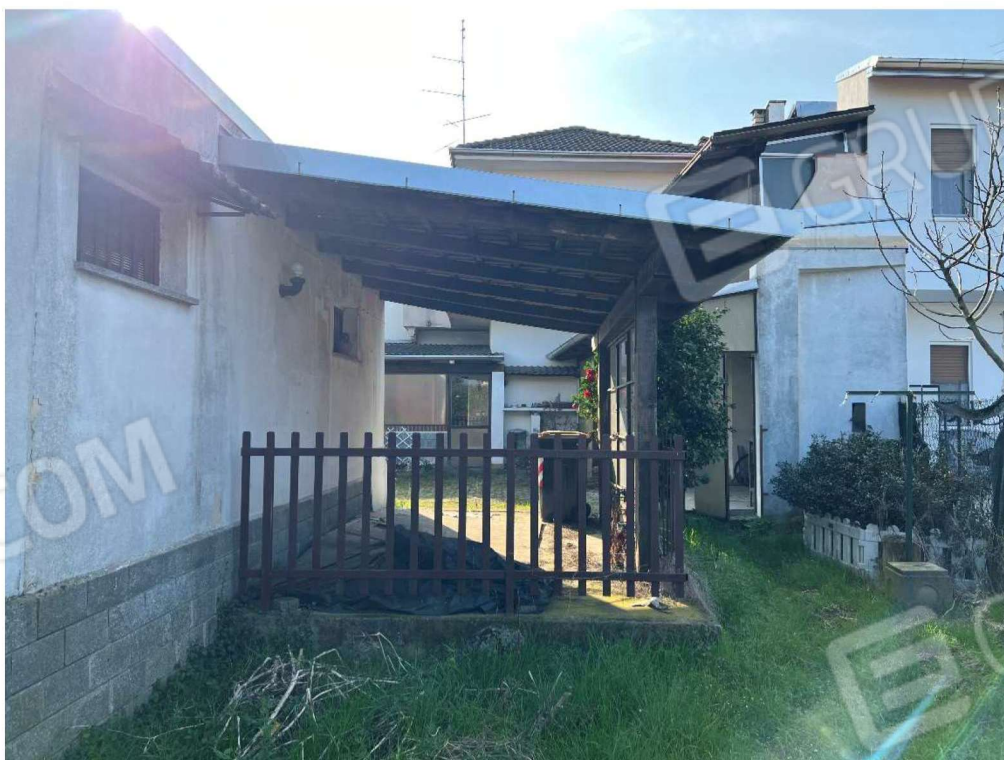
Accessorio Piano Terra – Tettoia
