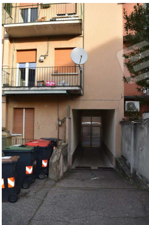
Foto 9: Prospetto su cortile interno, dettaglio accesso carraio
