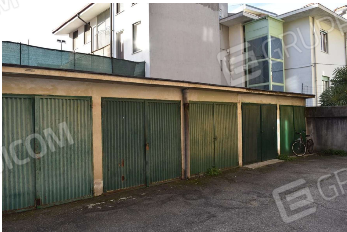
Foto 35: Blocco autorimesse, vista dal cortile interno
