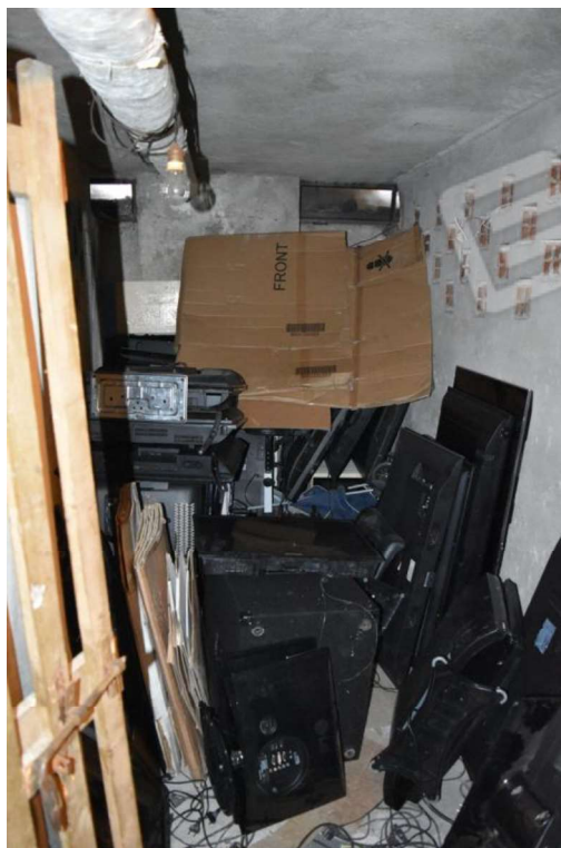
Foto 33: Cantina, vista interna
