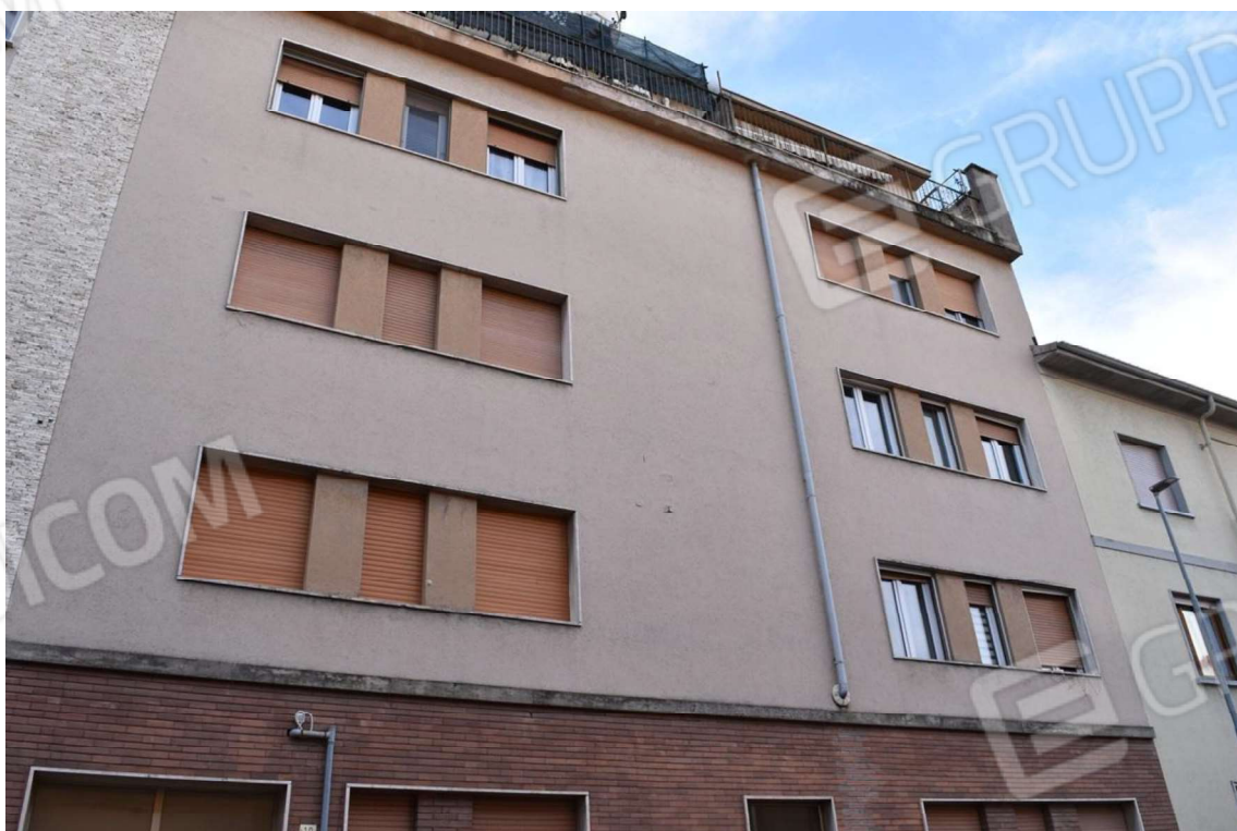
Foto 5: Prospetto su Via Morbio
