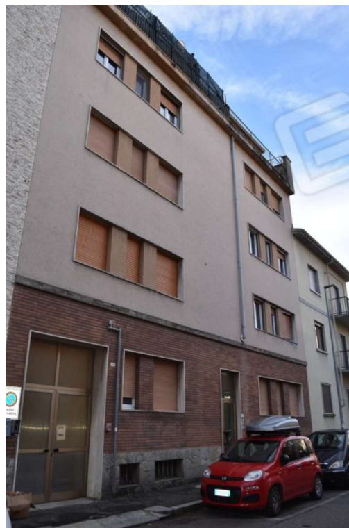
Foto 1: Prospetto su Via Morbio
