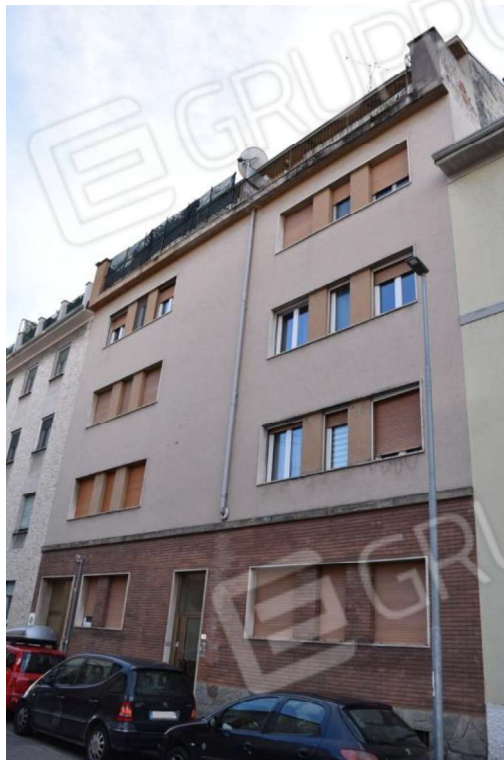
Foto 2: Prospetto su Via Morbio
