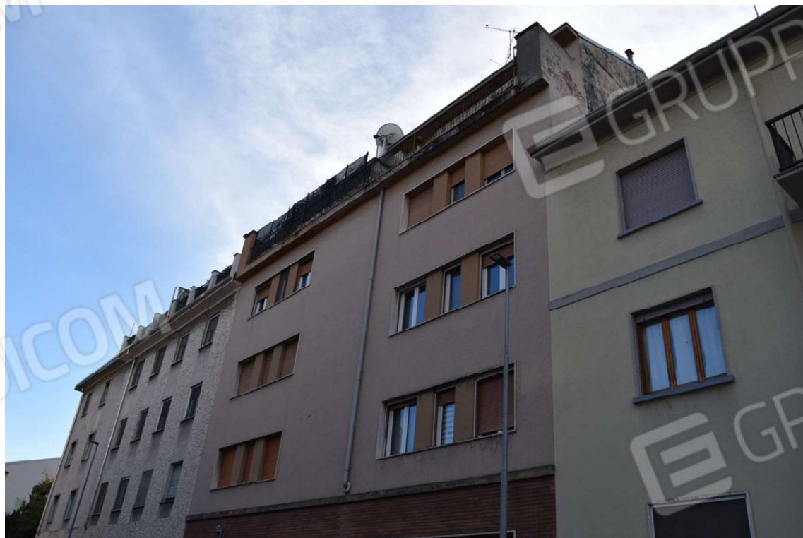
Foto 3: Prospetto su Via Morbio
