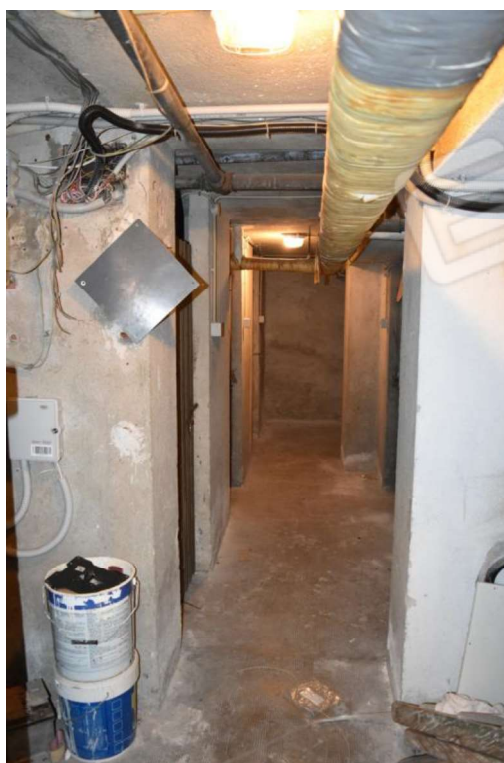
Foto 31: Cantina, vista del disimpegno comune
