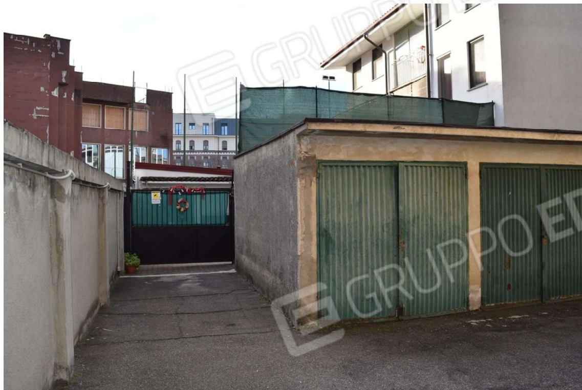
Foto 34: Blocco autorimesse, vista dal cortile interno
