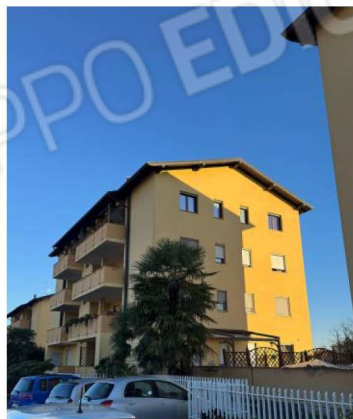
Vista prospetto Ovest
