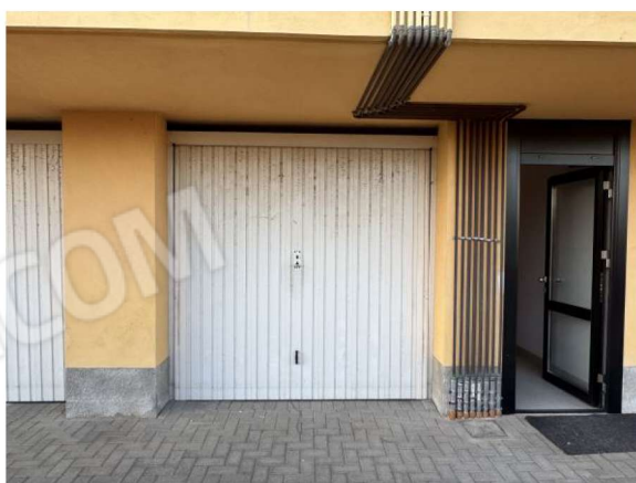
Vista autorimessa da area viabilità condominiale
