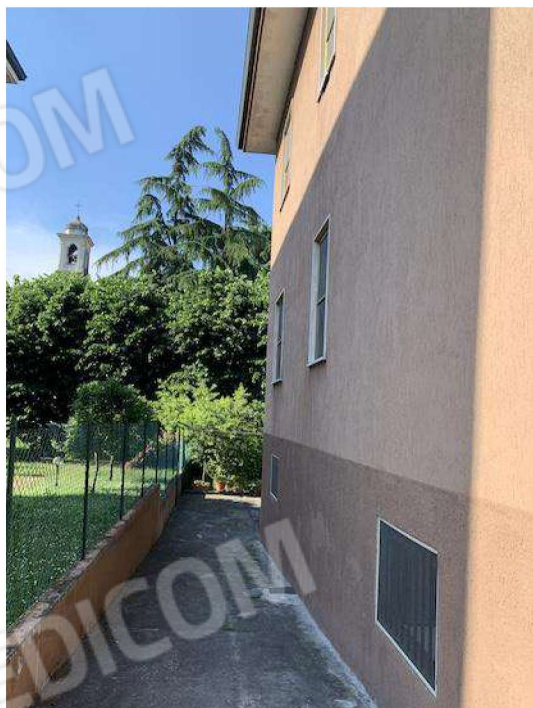
Foto 7: RECINZIONE LATO OVEST
