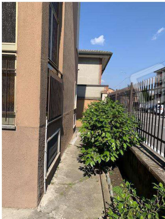
Foto 5: RECINZIONE LATO STRADA
