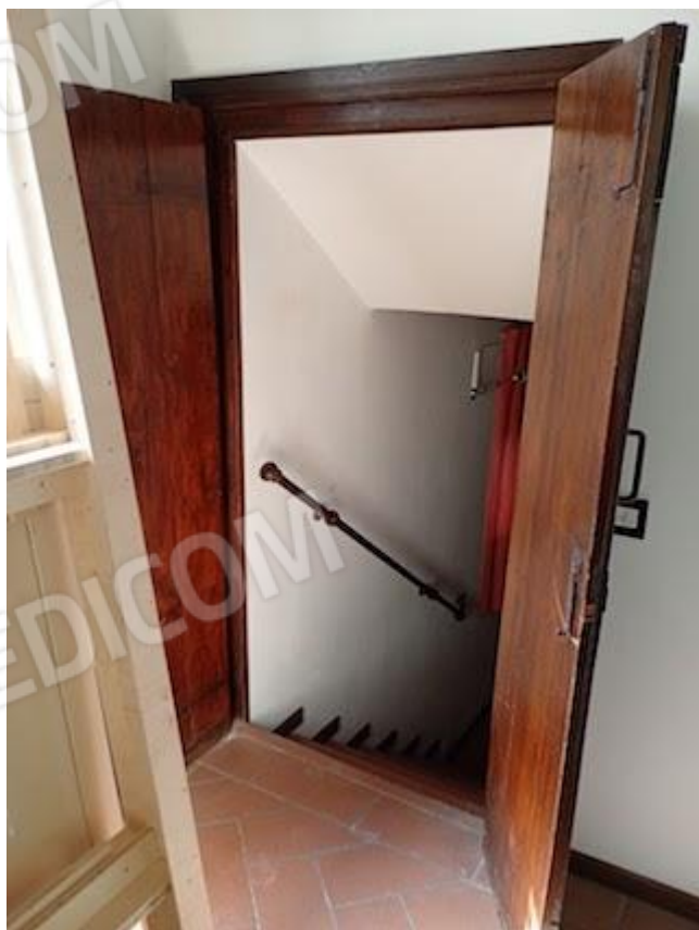
Porta per accesso sotterraneo
