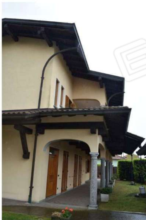
Foto 7: Lotto 1, abitazione, esterni
