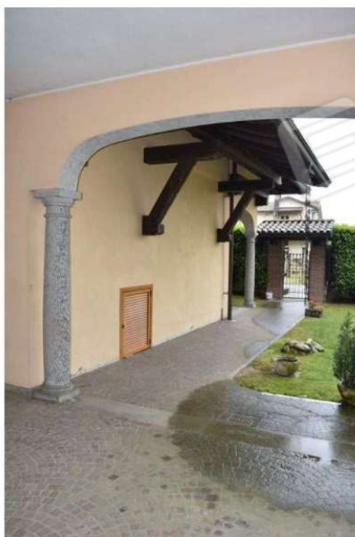
Foto 17: Lotto 1, abitazione, esterni
