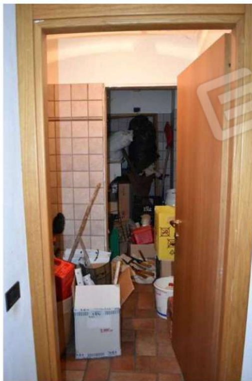
Foto 25: Lotto 1, abitazione, piano terra
