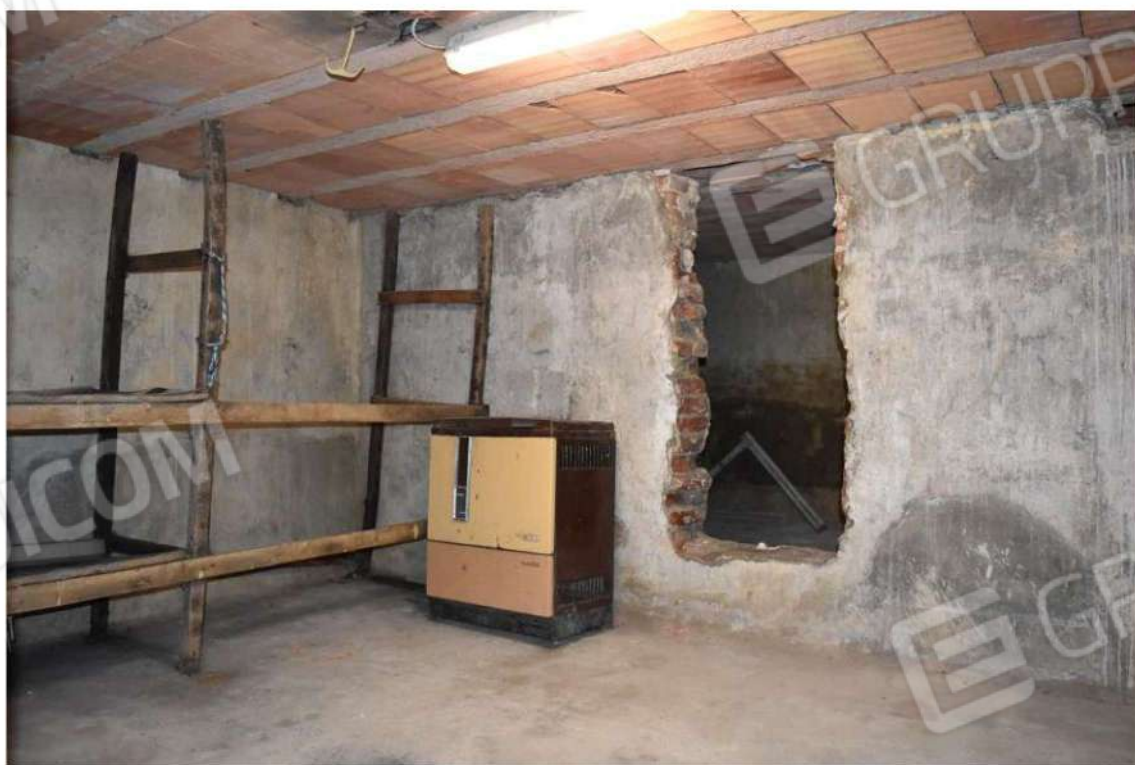
Foto 121: Lotto 2, magazzino (cantina), piano interrato
