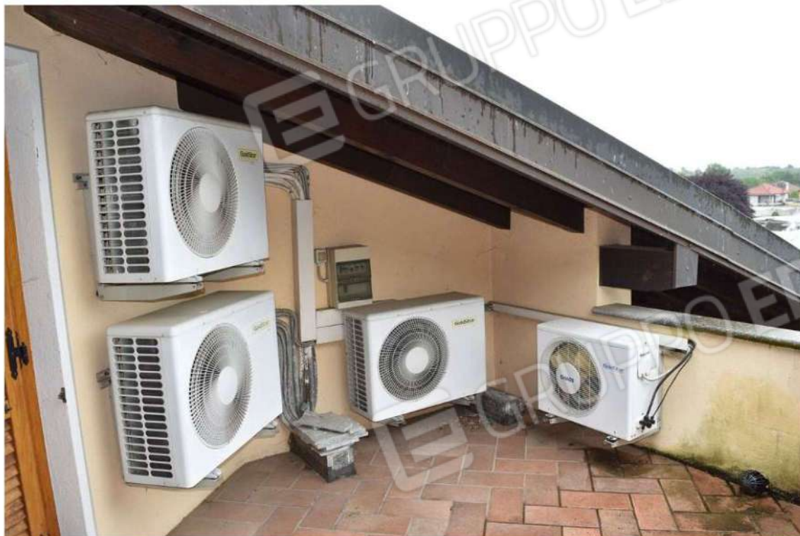
Foto 100: Lotto 1, abitazione, piano secondo (sottotetto)
