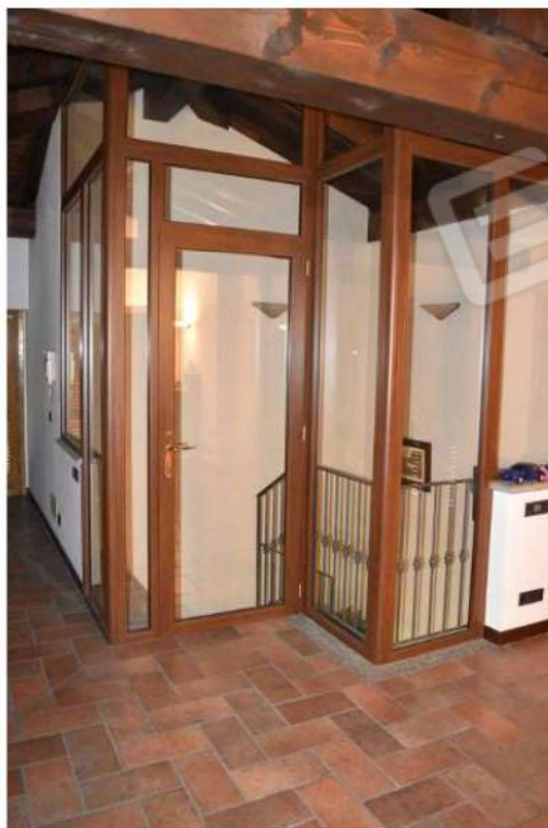
Foto 77: Lotto 1, abitazione, piano secondo (sottotetto)
