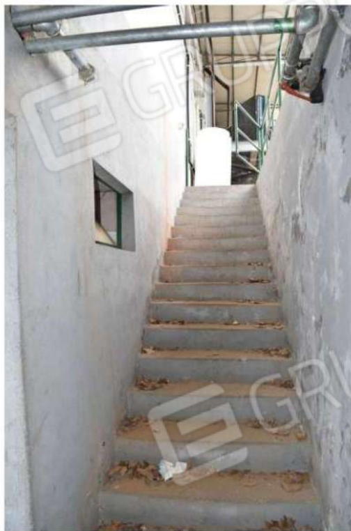
Foto 126: Lotto 2, magazzino (cantina), piano interrato
