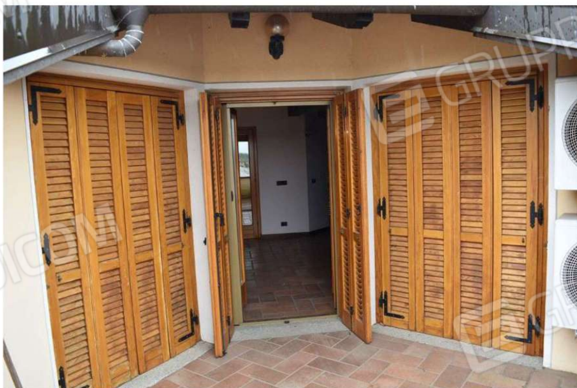
Foto 101: Lotto 1, abitazione, piano secondo (sottotetto)
