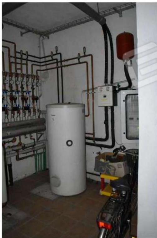
Foto 43: Lotto 1, abitazione, piano terra
