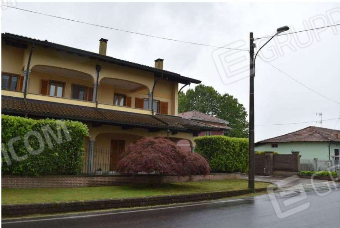
Foto 3: Lotto 1, abitazione, esterni
