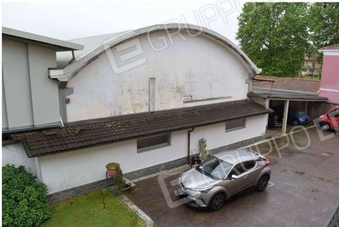
Foto 110: Lotto 2, magazzino (corridoio), piano terra
