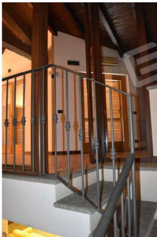
Foto 75: Lotto 1, abitazione, piano secondo (sottotetto)
