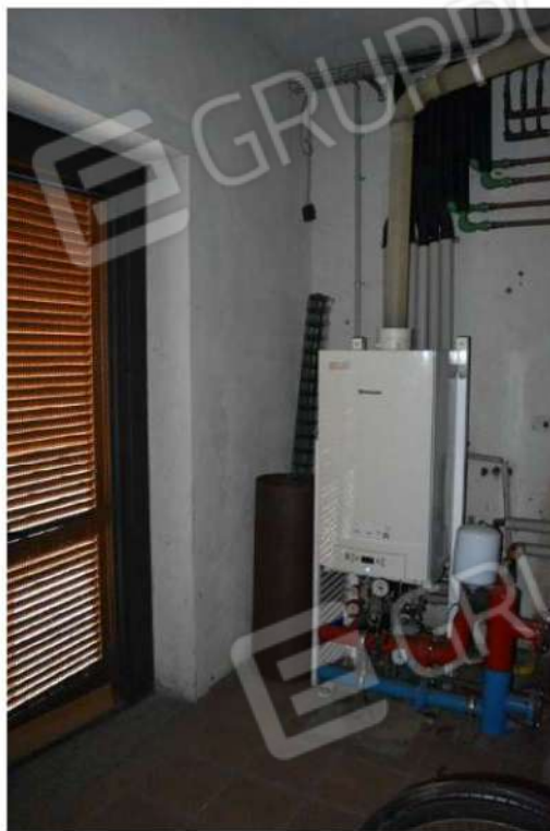
Foto 42: Lotto 1, abitazione, piano terra
