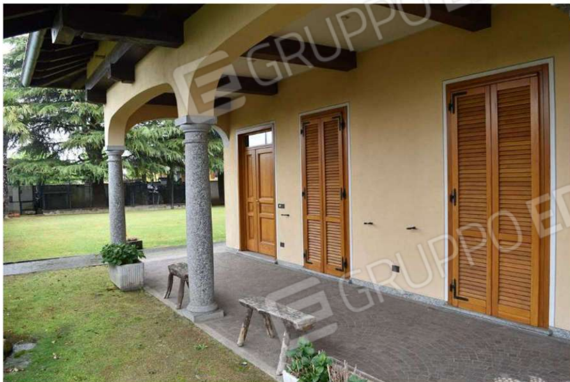
Foto 8: Lotto 1, abitazione, esterni
