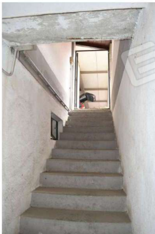
Foto 117: Lotto 2, magazzino (cantina), piano interrato
