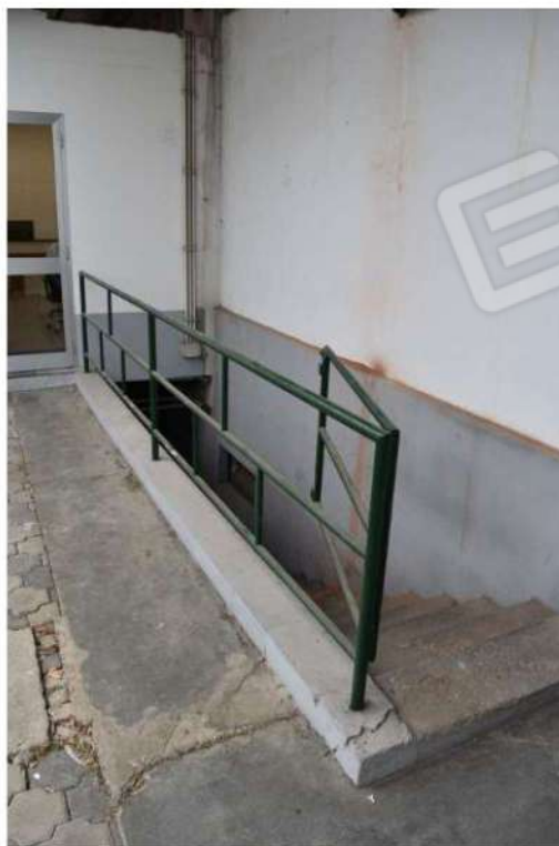
Foto 127: Lotto 2, magazzino (cantina), piano interrato
