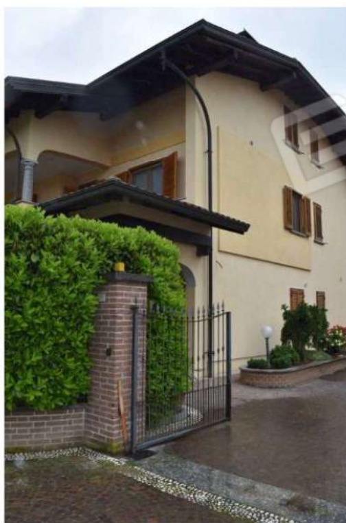
Foto 11: Lotto 1, abitazione, esterni
