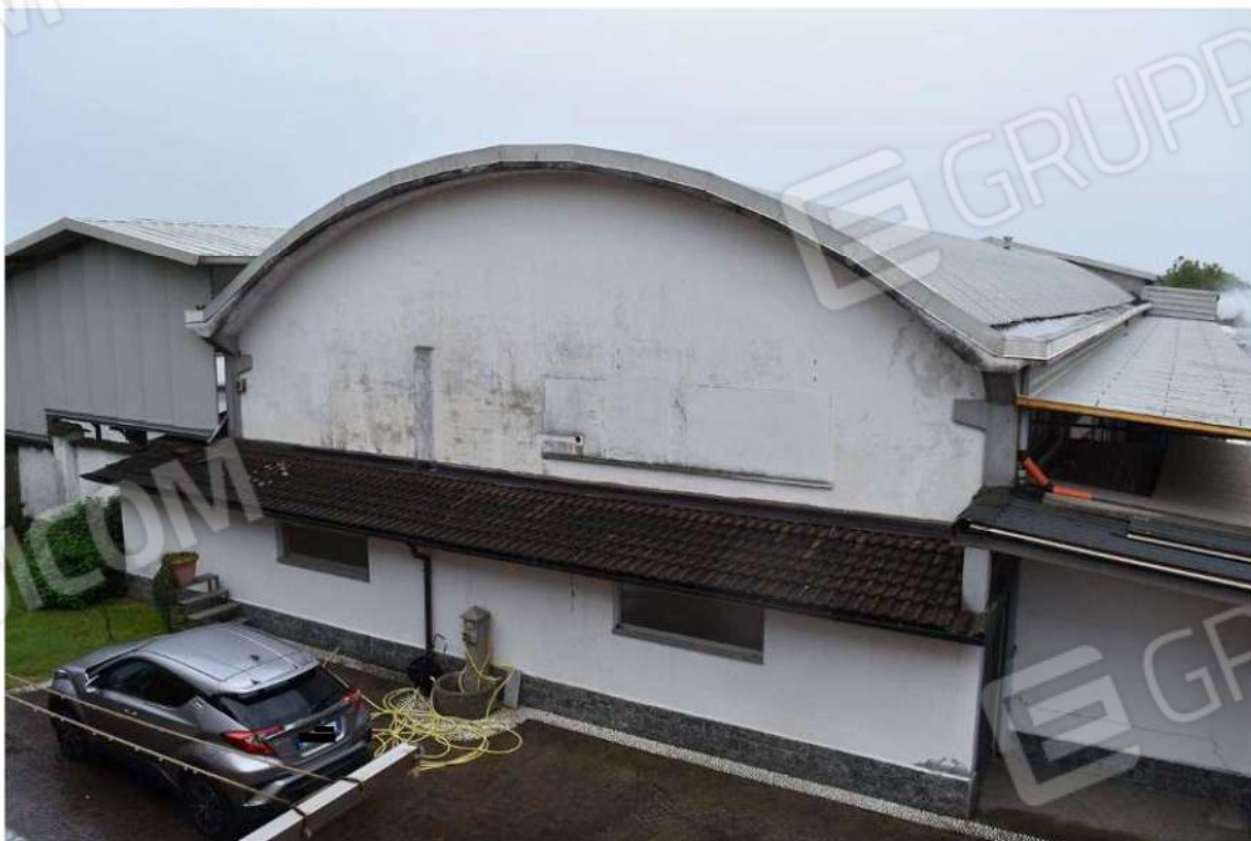
Foto 109: Lotto 2, magazzino (corridoio), piano terra
