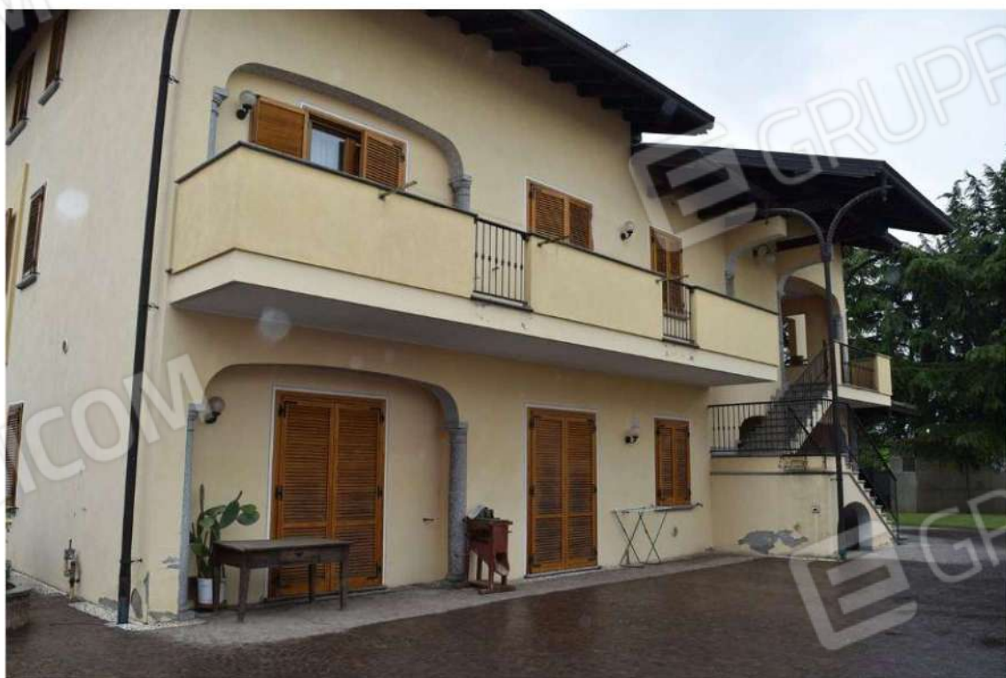
Foto 13: Lotto 1, abitazione, esterni
