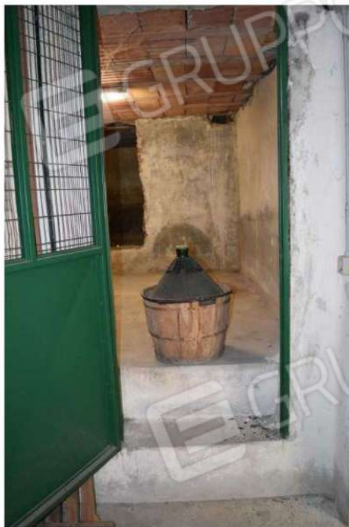
Foto 120: Lotto 2, magazzino (cantina), piano interrato
