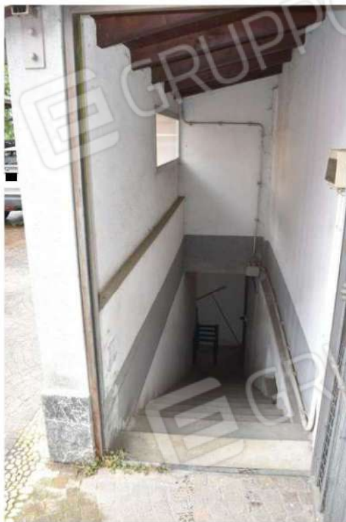
Foto 116: Lotto 2, magazzino (cantina), piano interrato
