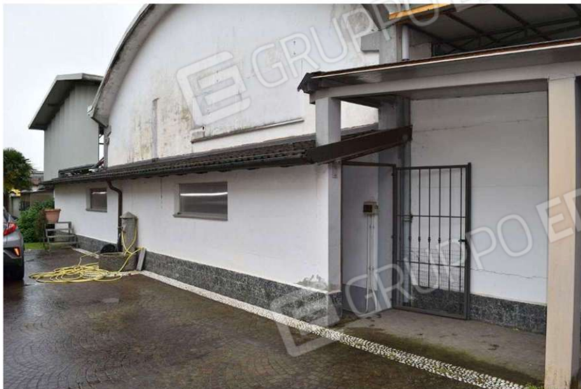
Foto 114: Lotto 2, magazzino (cantina), piano interrato
