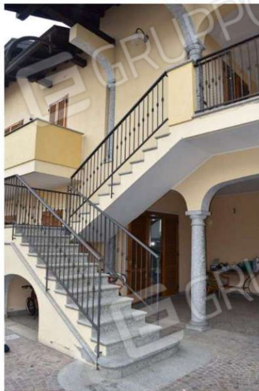
Foto 14: Lotto 1, abitazione, esterni
