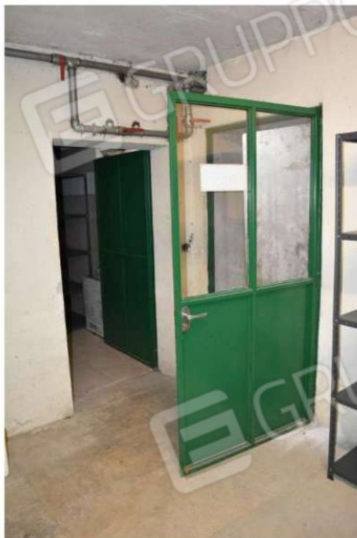
Foto 124: Lotto 2, magazzino (cantina), piano interrato
