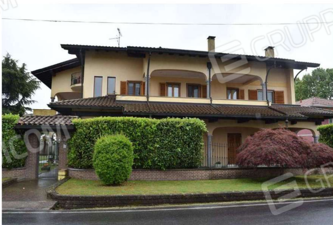
Foto 1: Lotto 1, abitazione, esterni
