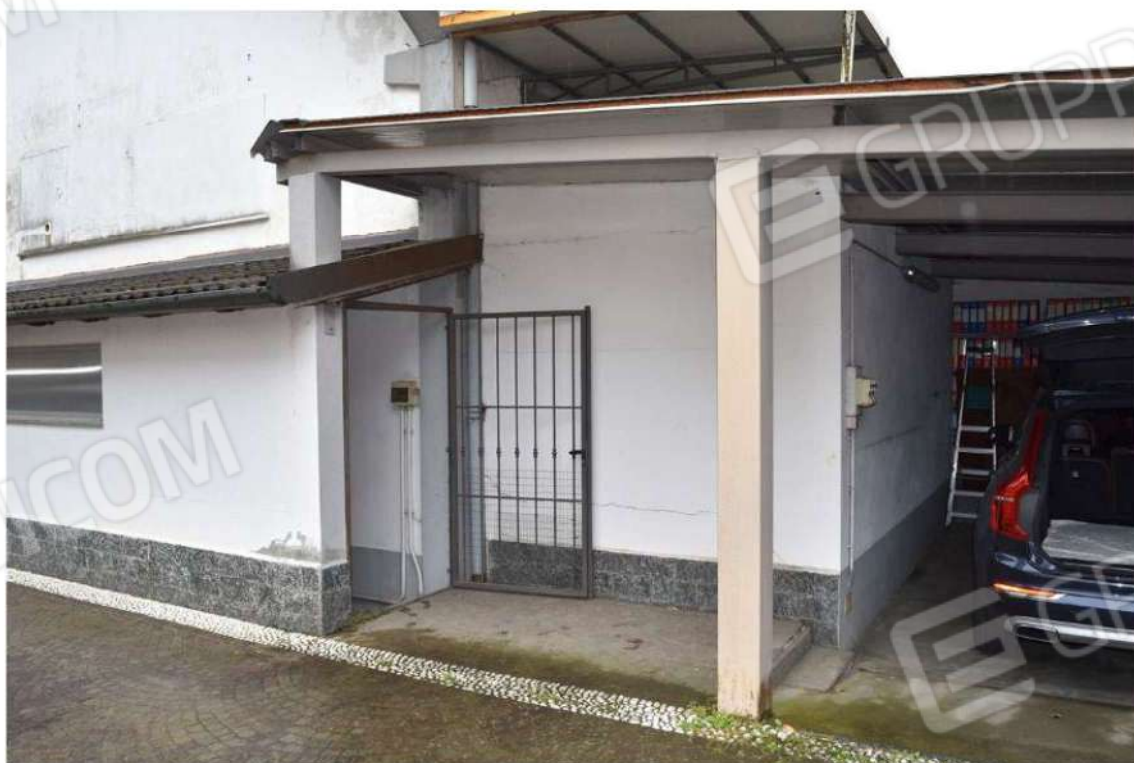
Foto 115: Lotto 2, magazzino (cantina), piano interrato
