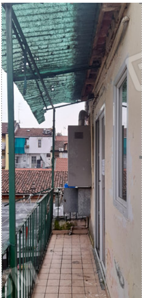
Foto 9 – vista ingresso ballatoio
