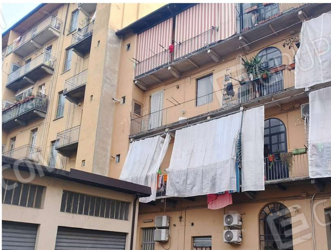
Foto n. 3: prospetto lato cortile
