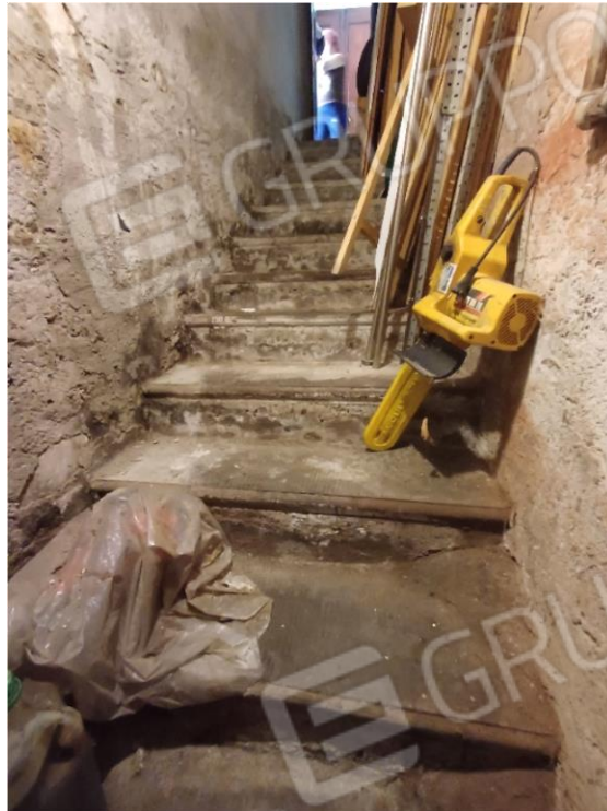
Foto 27 – Scala accesso cantina
