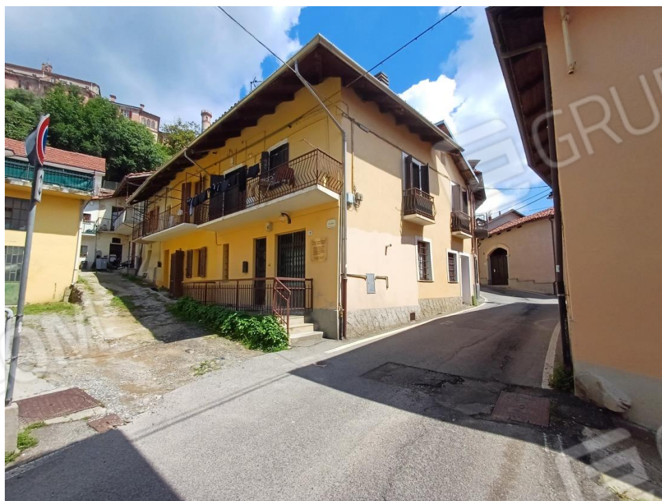
Foto 7 – Via Roma e passaggio laterale
