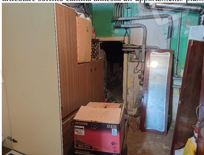
Foto 36 -Cantina e C.T.
