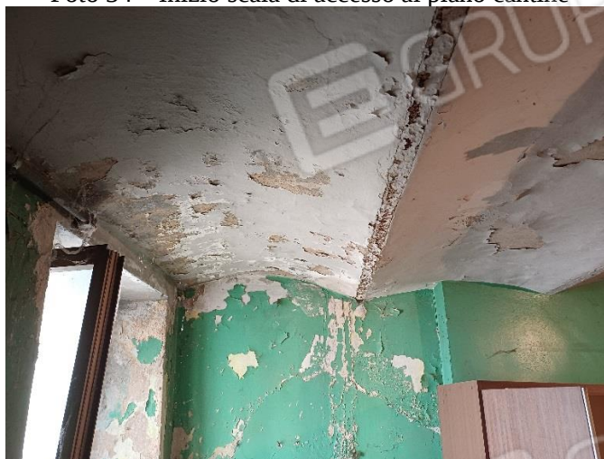
Foto 35 – Particolare soffitto cantina annessa all'appartamento piano primo-terra
