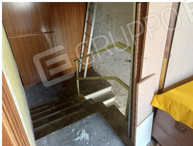
Foto 34 – Inizio scala di accesso al piano cantine
