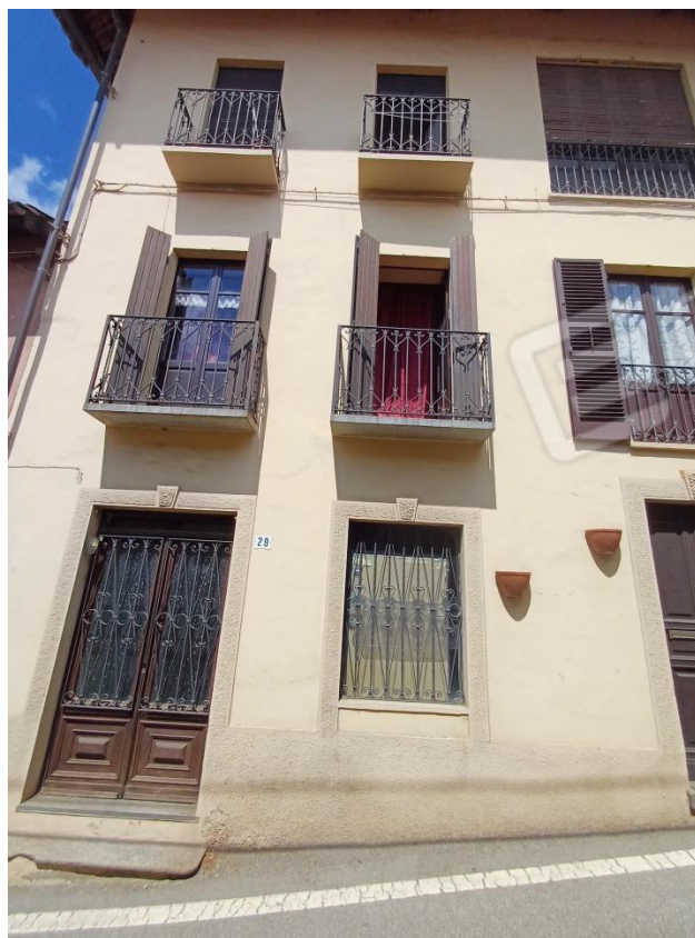
Foto 5 – Facciata su Via Roma
