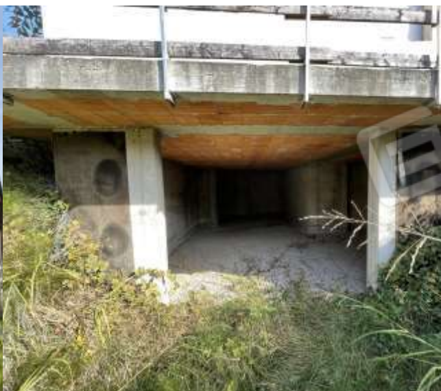
INGRESSO PIANO INTERRATO
