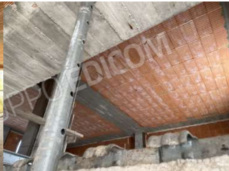
PIANO TERRA - VISTA SUL SOLAIO DEL PIANO PRIMO
