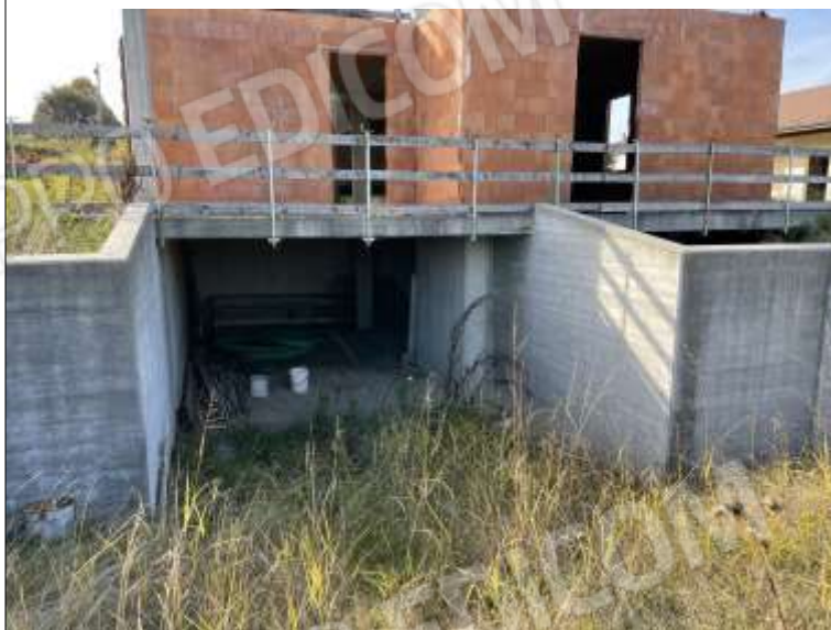
INGRESSO PIANO INTERRATO
