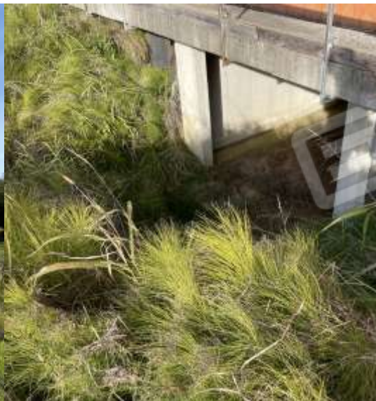
INGRESSO PIANO INTERRATO
