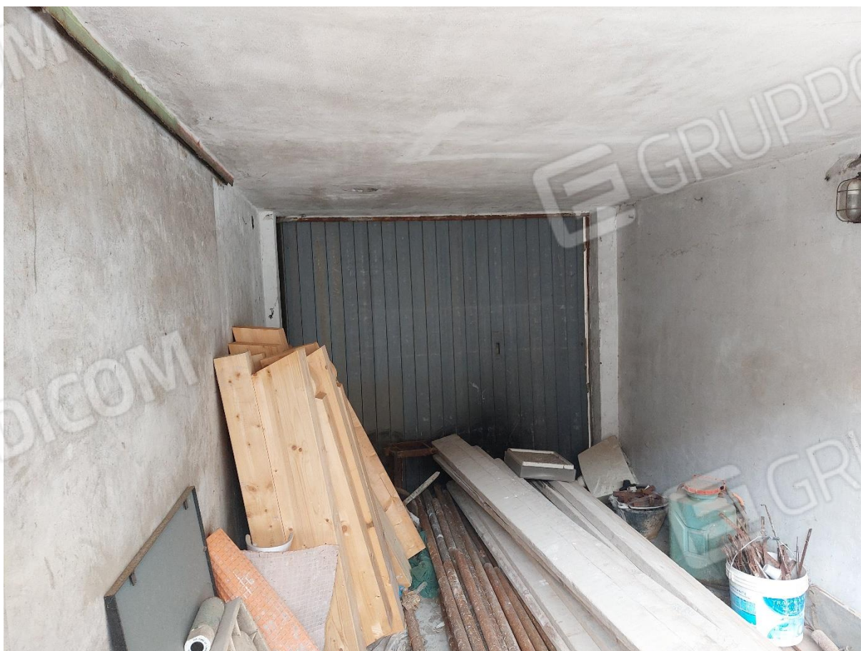
FOTO 8 – Passaggio comune coperto -“LOTTO 2”
