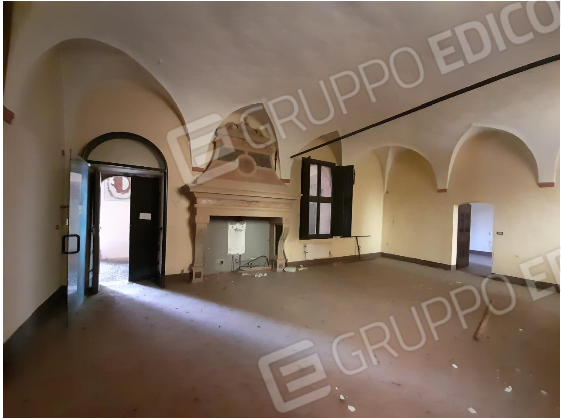
Foto 19 – Ingresso con ampio locale laboratorio
