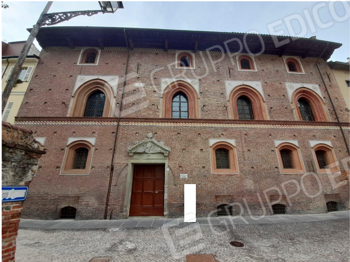
Foto 1 - Ingresso principale da Via Canina n.13
