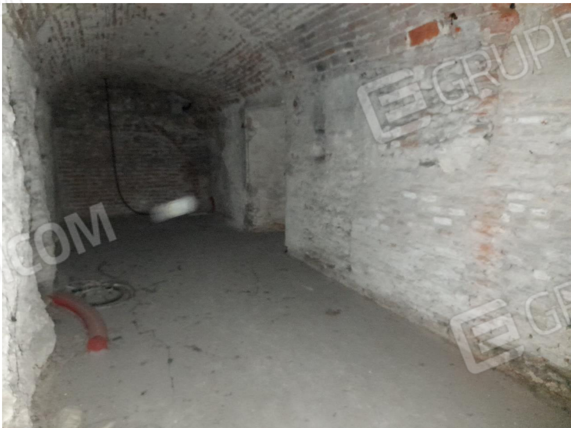
Foto 10 – Locale cantina sub.40
