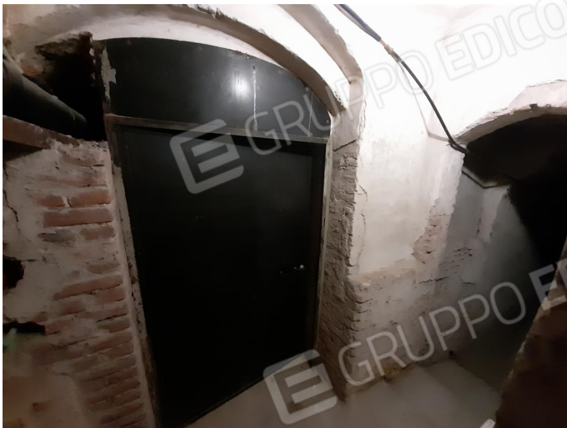
Foto 27 – Ingresso cantina sub.39
