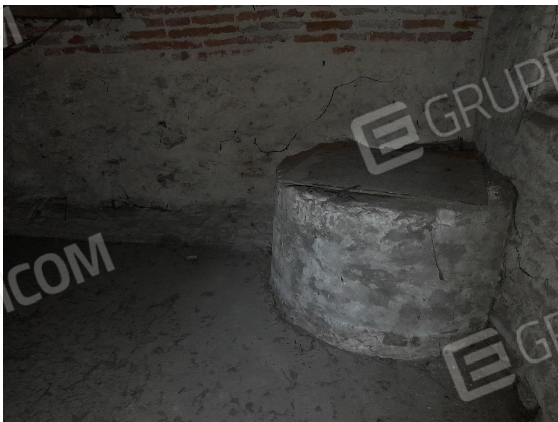
Foto 14 – Locale cantina sub.40
