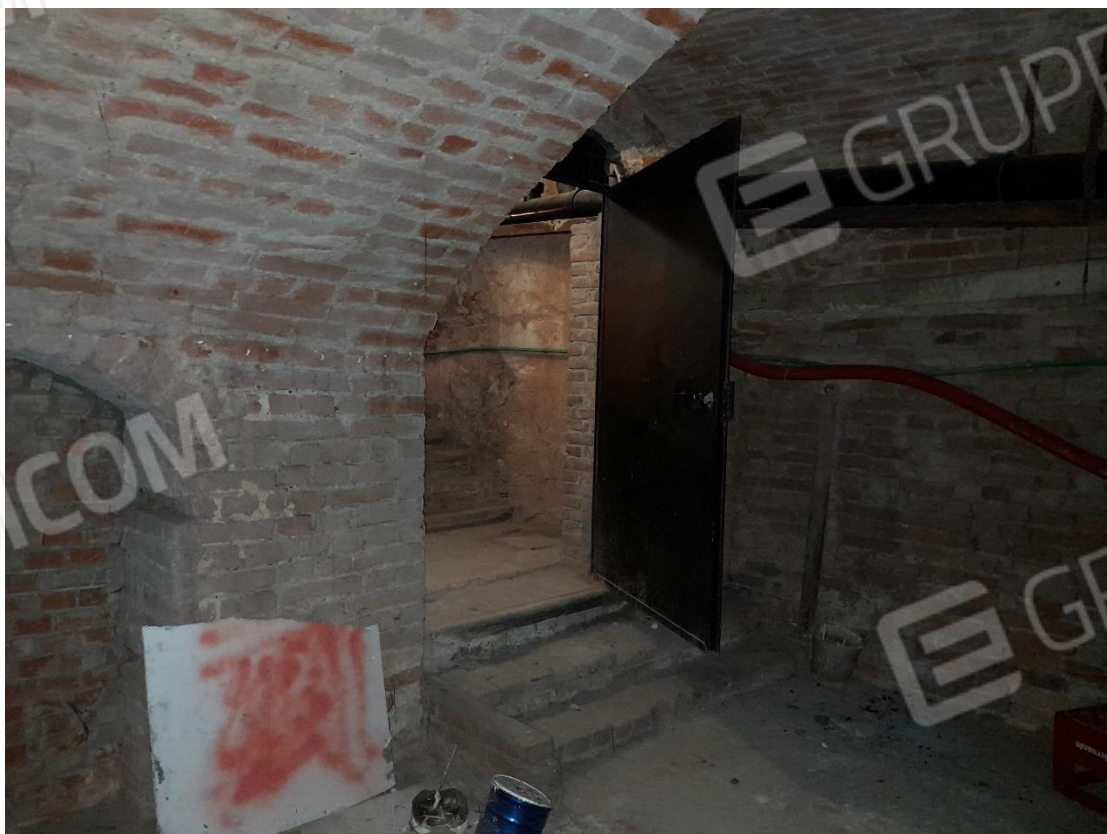
Foto 28 – Ingresso cantina sub.39
