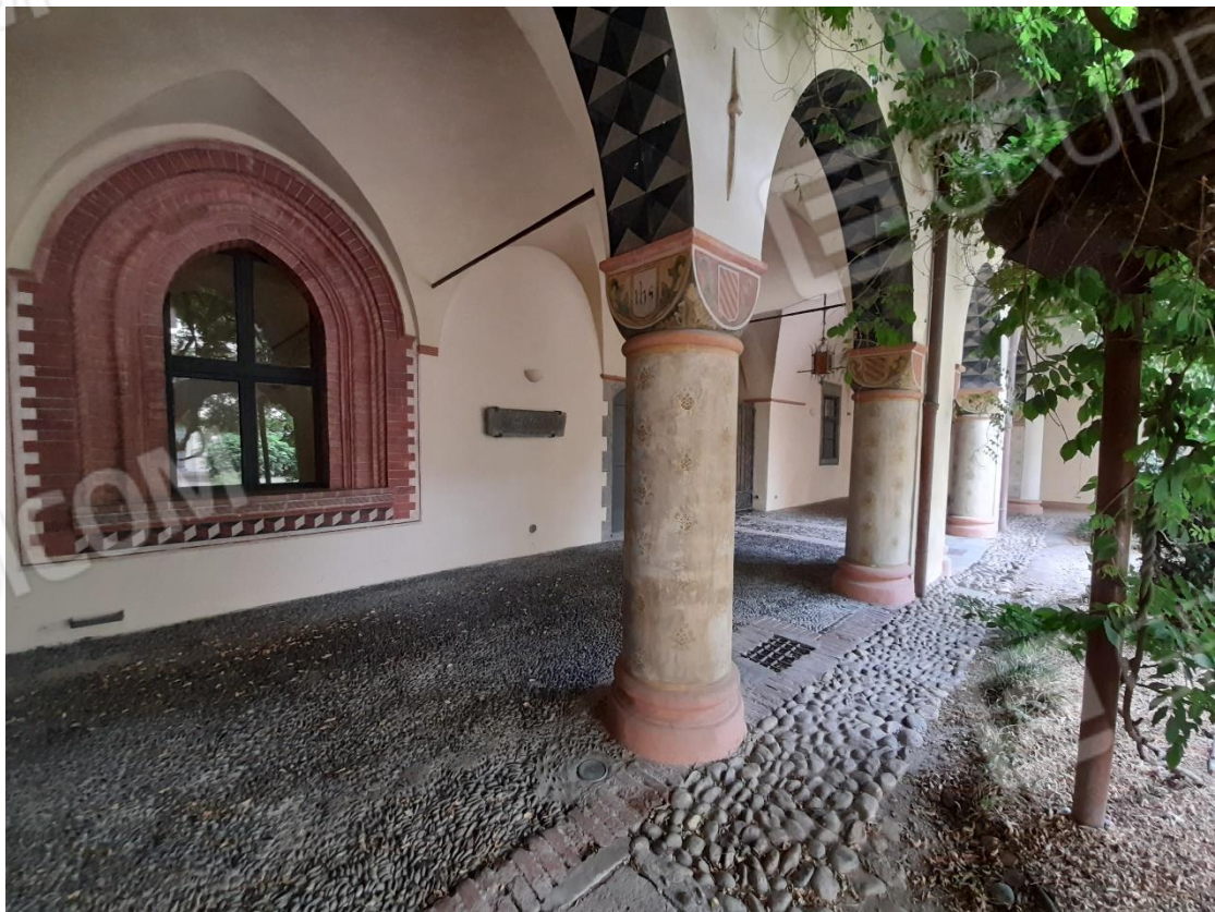
Foto 18 – Finestra laboratorio lato cortile
