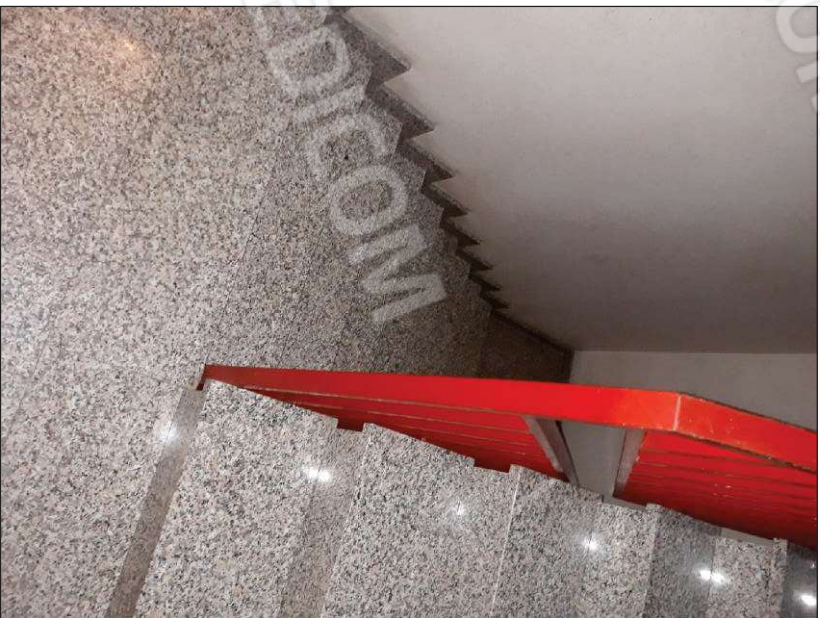
Vano scale comune
