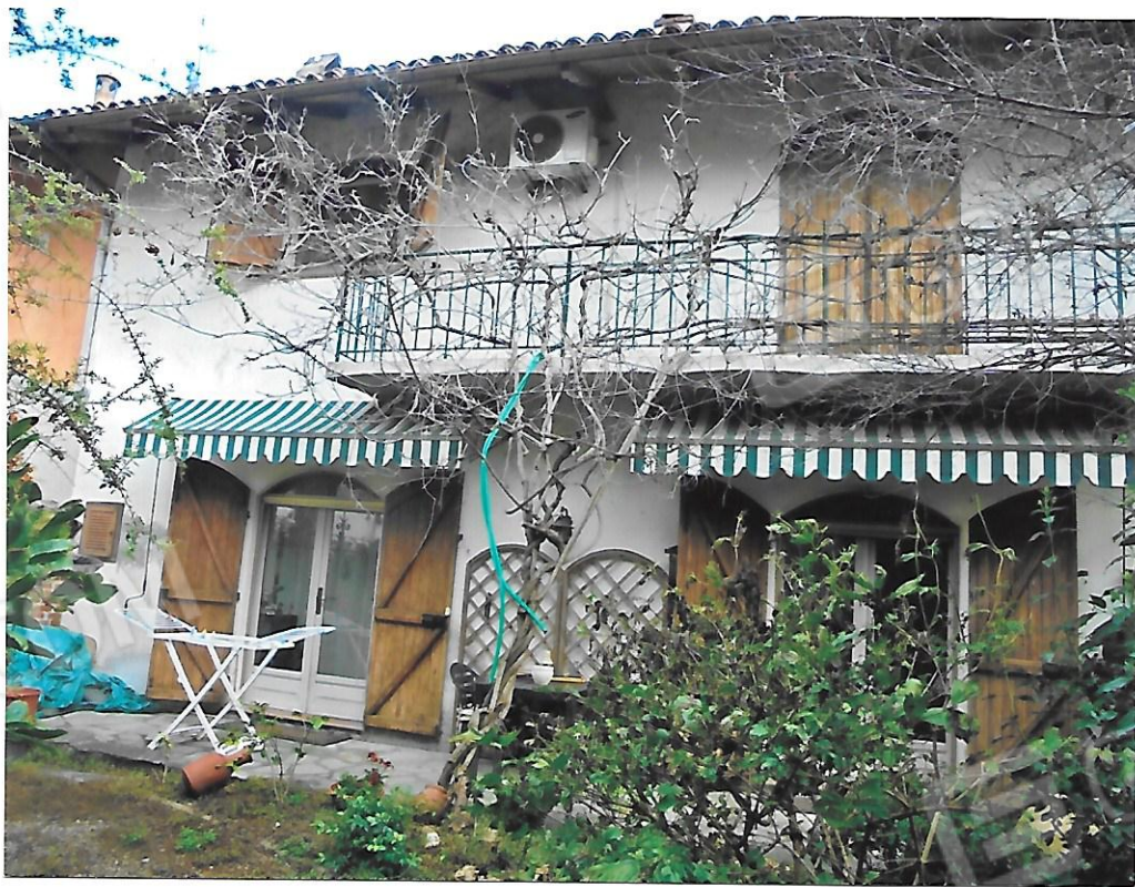
Foto 2 – Facciata interna su cortile
