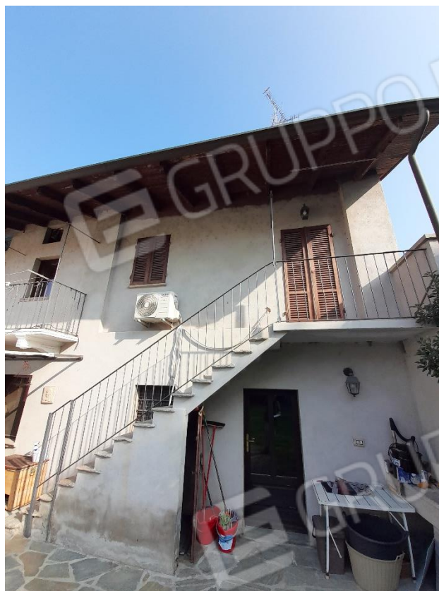
FOTO 7 – Scala esterna di accesso al piano primo
