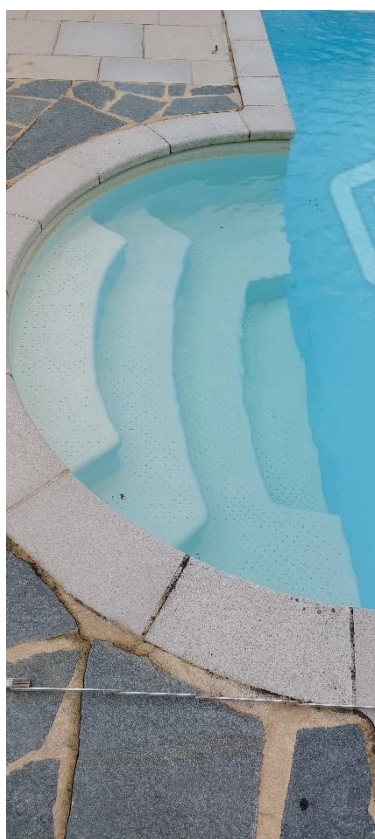
FOTO 13 – Scala di accesso alla piscina
