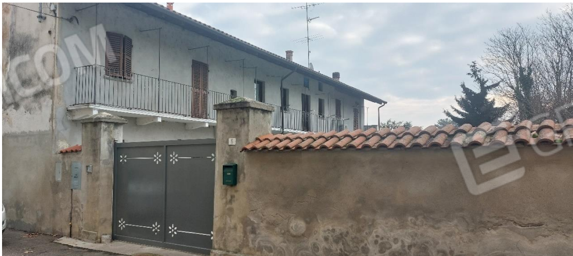
FOTO 3 – Ingresso carroia su via Mercurino da Gattinara
