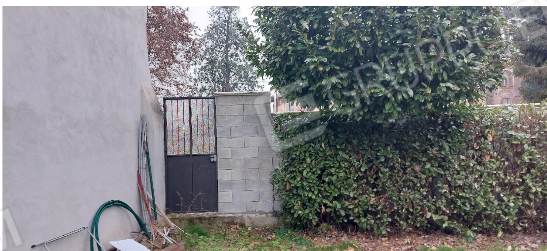
FOTO 10 – Accesso pedonale a confine delle particelle 461 e 183
