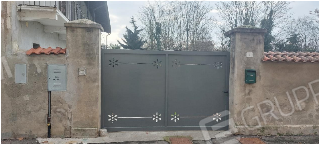
FOTO 2 – Ingresso carroia su via Mercurino da Gattinara
