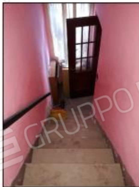
18 - Scala da p.terra a p.primo
