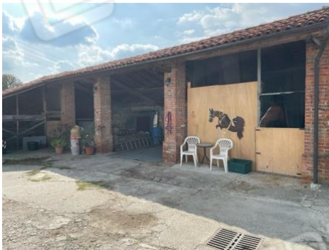
Immagine 3: Foto porticato entro lotto di terreno di proprietà, e corte.
