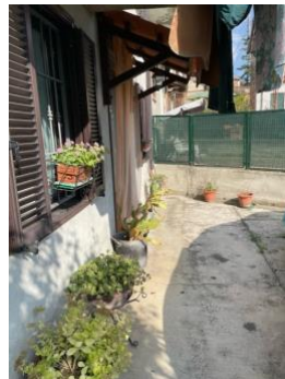
Immagine 10: Foto fabbricato civile, ingresso secondario sul soggiorno.
