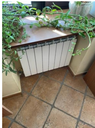
Immagine 17: Foto interni del fabbricato civile, piano terreno, cucina, particolare radiatori riscaldamento.
