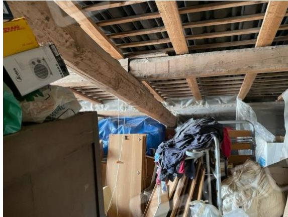
Immagine 39: Foto interni del fabbricato civile, piano primo, sottotetto.
