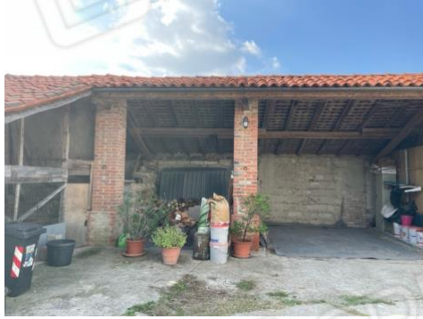
Immagine 6: Foto porticato entro lotto di terreno di proprietà, e corte.
