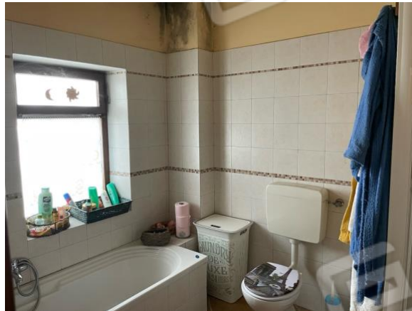
Immagine 37: Foto interni del fabbricato civile, piano primo, bagno.
