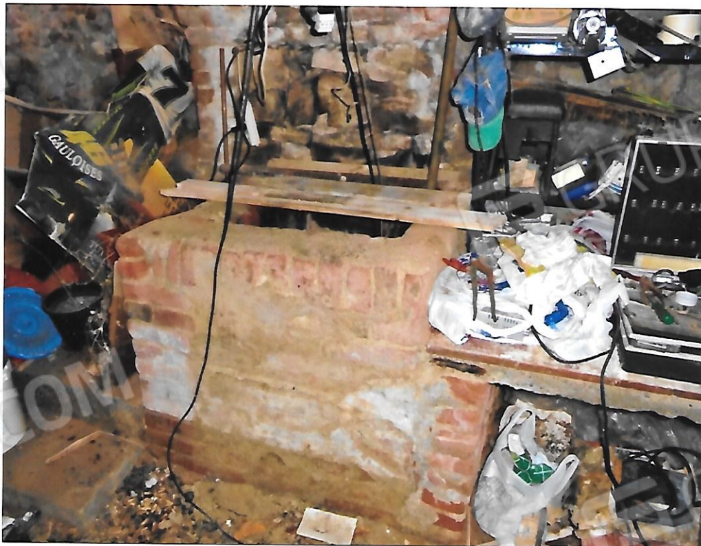
Foto 14 - Pozzo nel locale cantina
