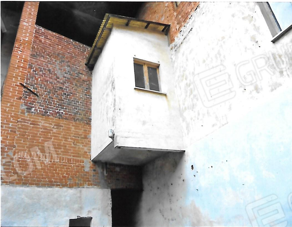
Foto 14 – Bagno Mapp.296 sub.6 visto da esterno
