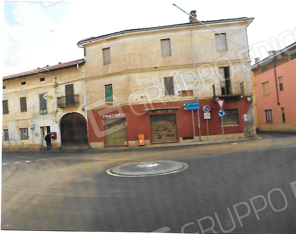
Foto 1- Fronte principale su Piazza Libertà
