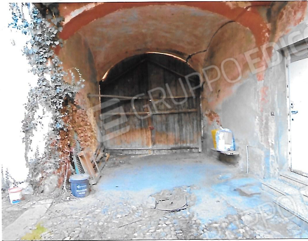
Foto 7- Androne carraio visto da interno cortile
