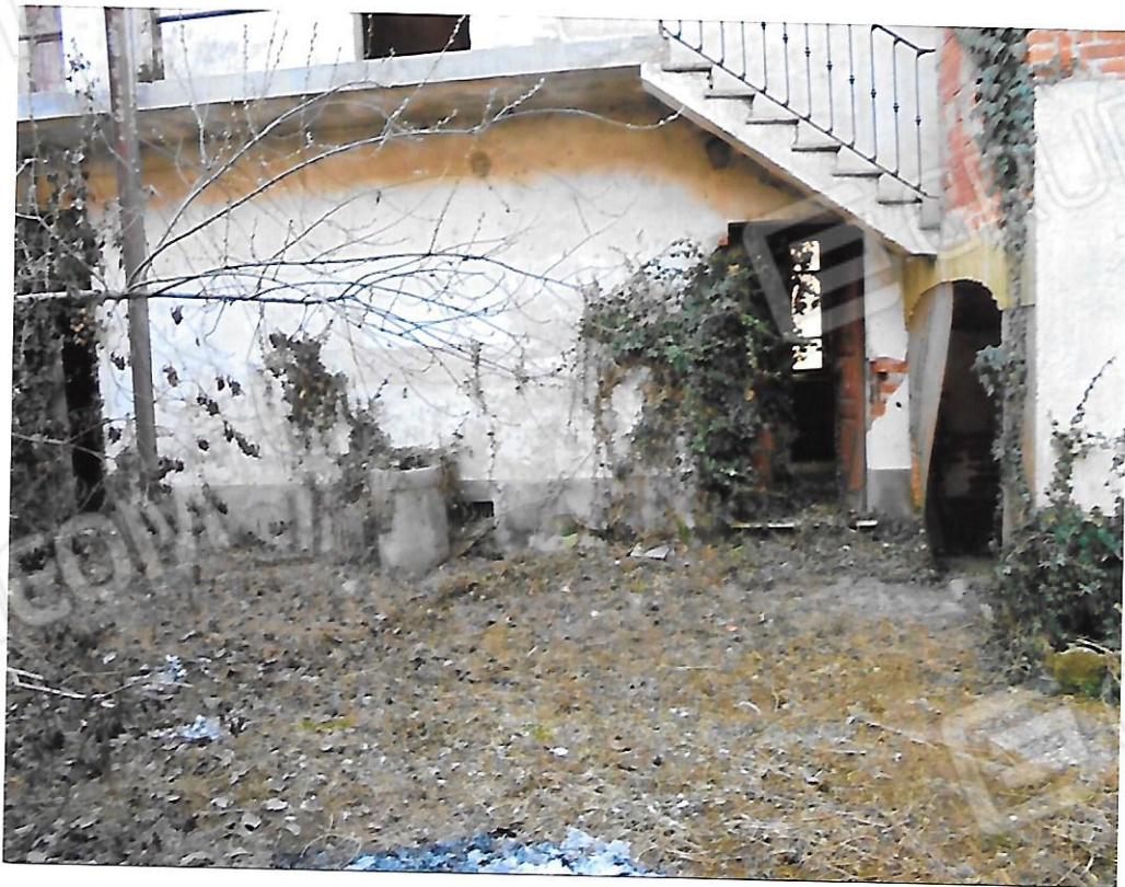
Foto 4 – Unico ingresso da cortile
