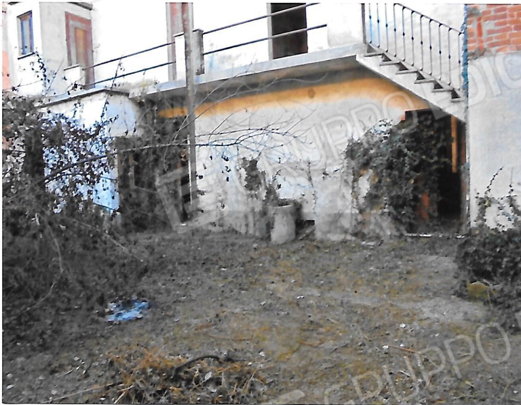
Foto 5- Fronte su cortile mappale 296 sub.5
