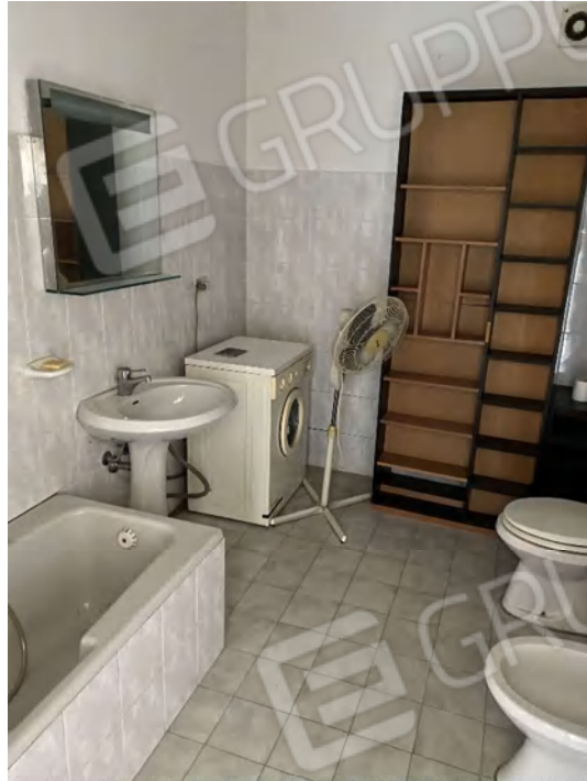
BAGNO (SUB 7) pavimento e rivestimento
