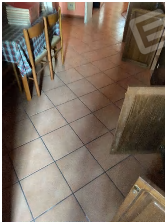
CUCINA (SUB. 5) pavimento
