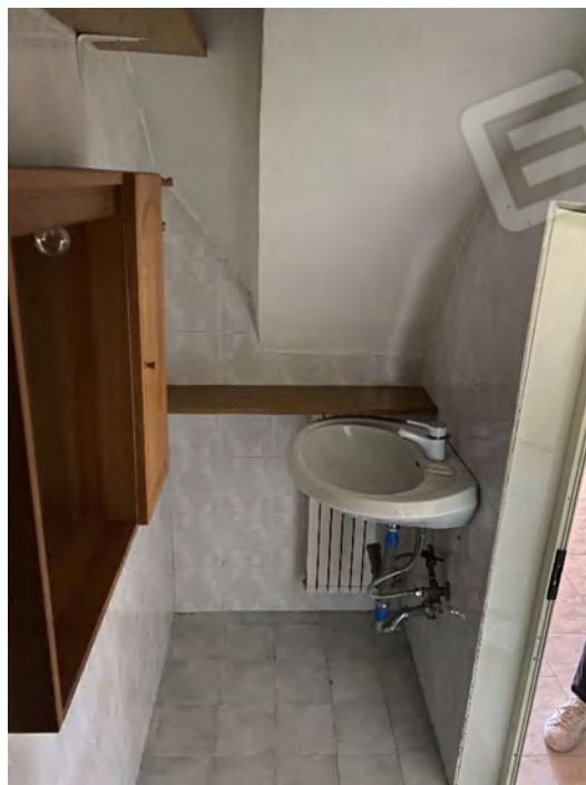
BAGNO (B) (SUB. 5) soffitto
