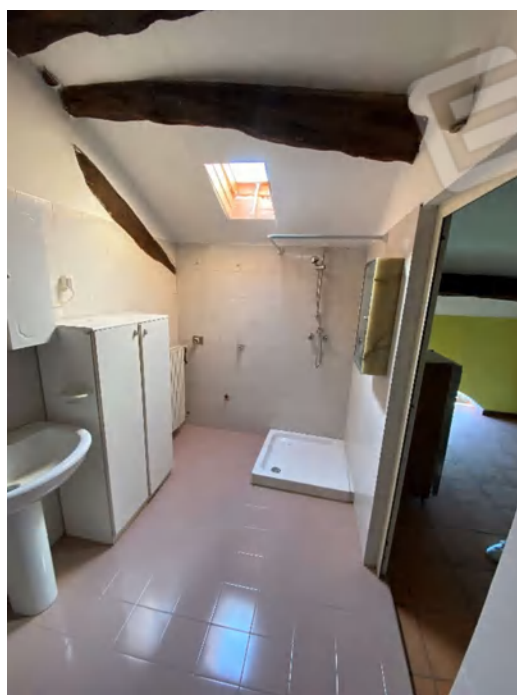
BAGNO (SUB. 9) pavimento, rivestimento e soffitto
