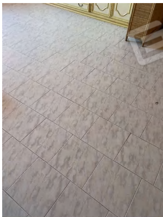
SOGGIORNO "B,, (SUB. 5) pavimento
