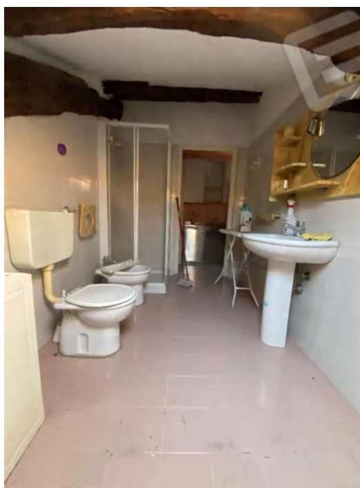
BAGNO (SUB. 8) pavimento, rivestimento e soffitto
