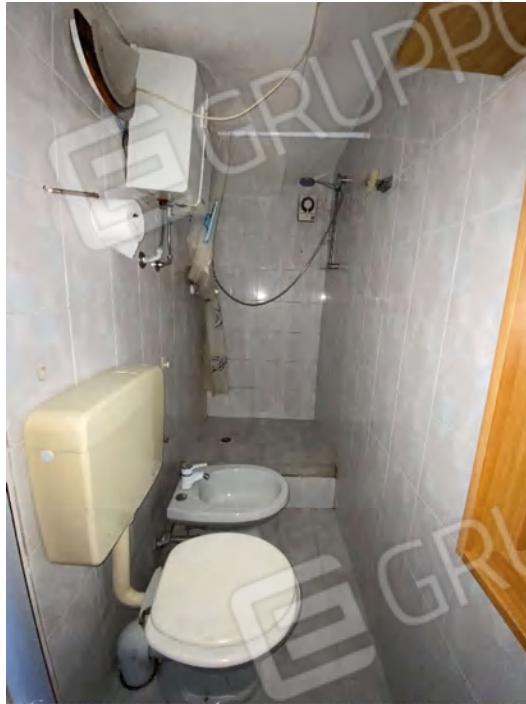
BAGNO (B) (SUB. 5) pavimento e rivestimento pareti
