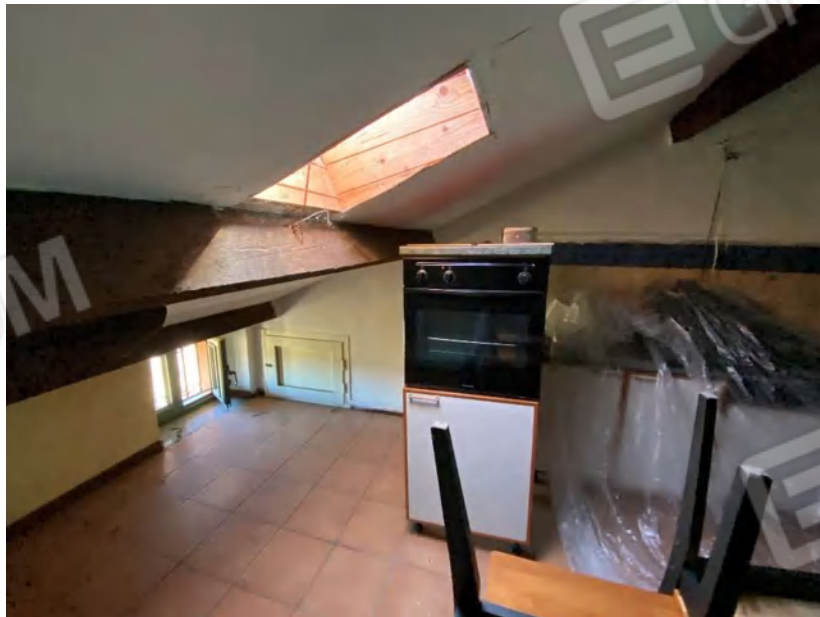
CUCINA/CAMERA (SUB 10) pavimento e soffitto
