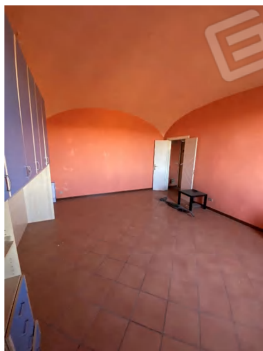
CAMERA "A,, (SUB. 5) pavimento e soffitto
