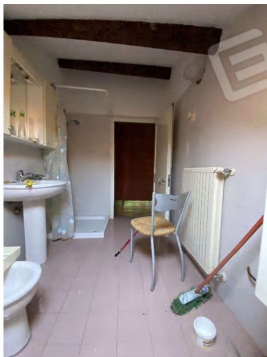
BAGNO (SUB. 10) pavimento, rivestimento e soffitto
