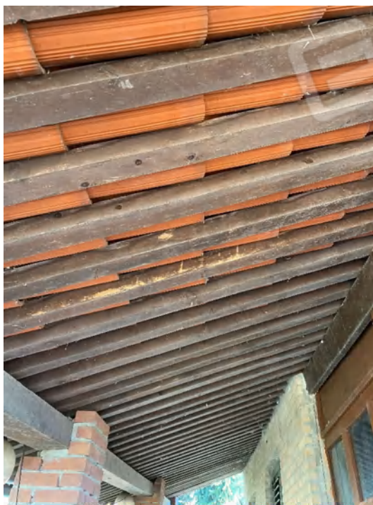
PORTICATO manto di copertura
