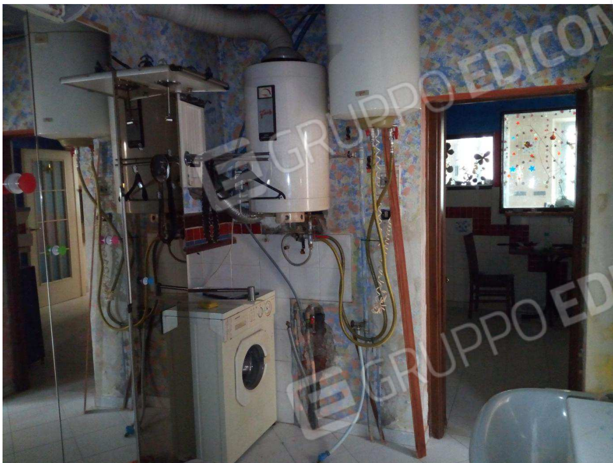
Immagine 29. Locale n. 10 (Bagno n. 1)
