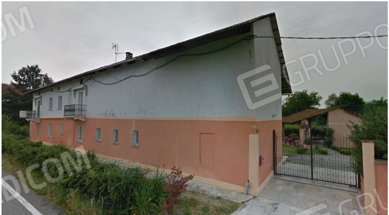
Foto 4 – Vista generale dell'immobile dalla strada
