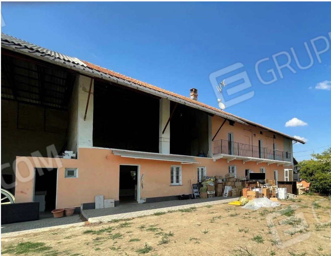
Foto 2 – Vista generale dell'abitazione dal cortile
