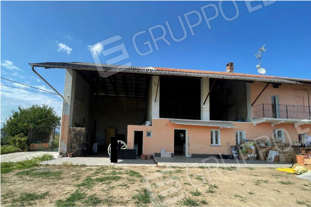
Foto 1 – Vista generale dell'abitazione dal cortile
