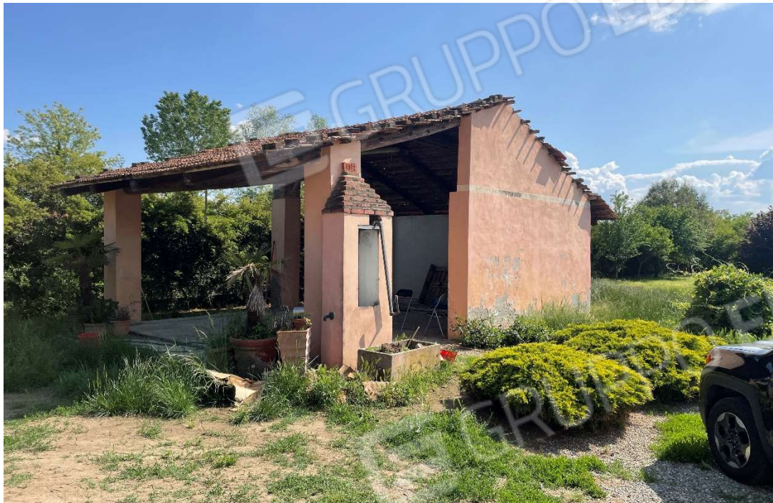
Foto 3 – Vista generale della tettoia isolata
