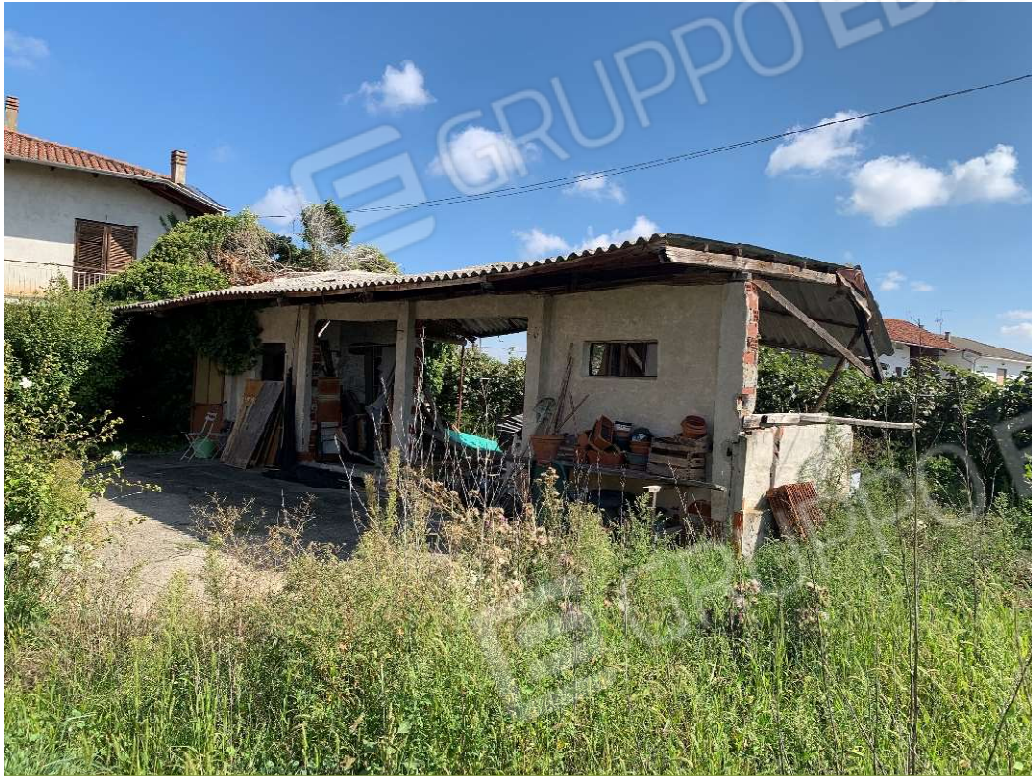
Foto 3 – Vista generale della tettoia isolata
