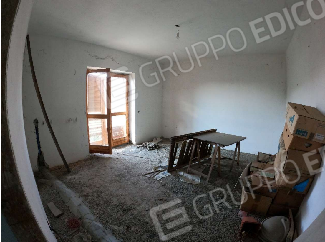
Foto 9 – Camera appartamento P1 zona cortile
