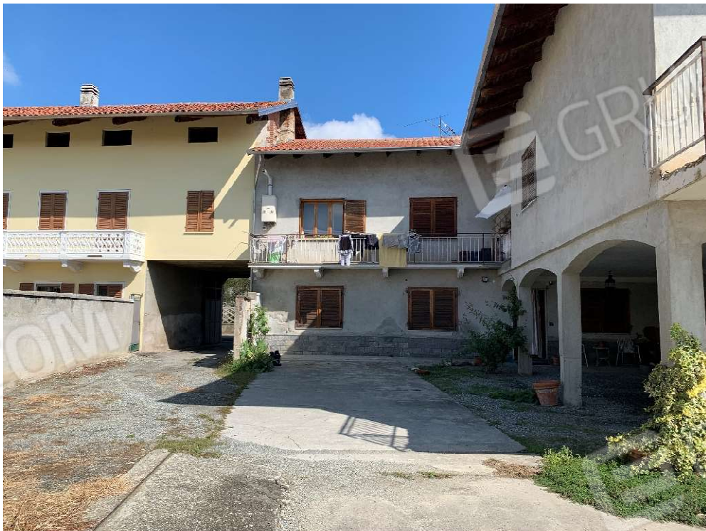
Foto 2 – Vista generale dell'abitazione dal cortile
