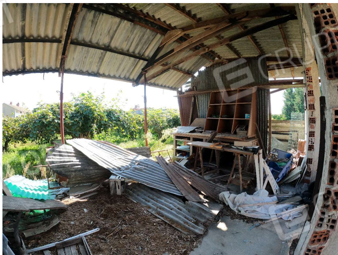
Foto 6 – Interno della tettoia
