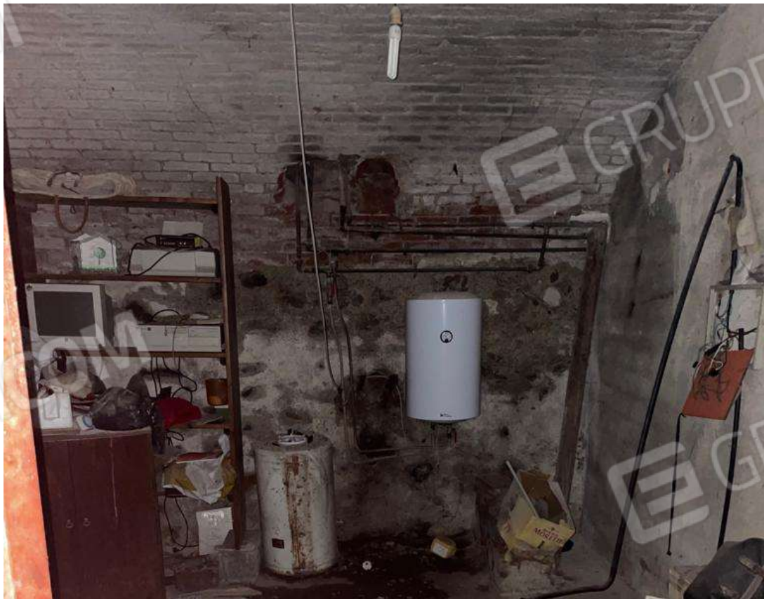
Foto 22 – Cantina piano interrato lato strada
