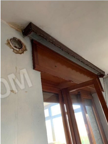
INFILTRAZIONI P1° CAMERA
