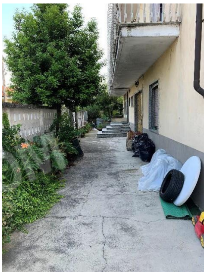
ESTERNO LATO EST
