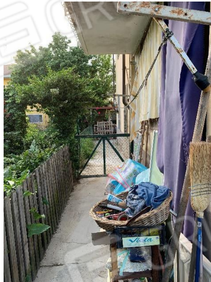
ESTERNO LATO SUD
