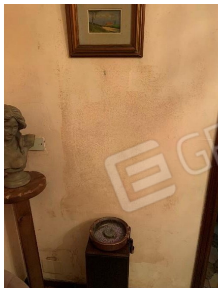
INFILTRAZIONI P1° DISIMPEGNO
