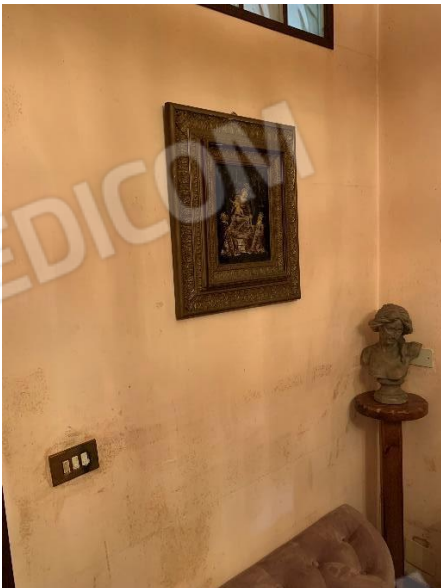
INFILTRAZIONI P1° CAMERA
