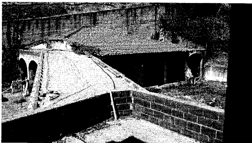
Figura 11: vista degli immobili 2 e 3
