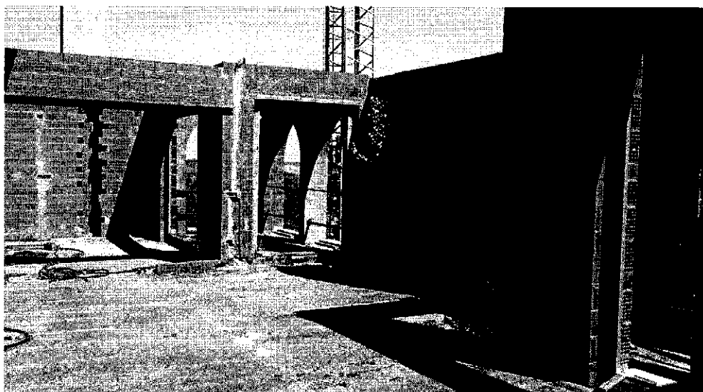
Figura 8: ambienti dell'immobile 1 zona ex sottotetto
