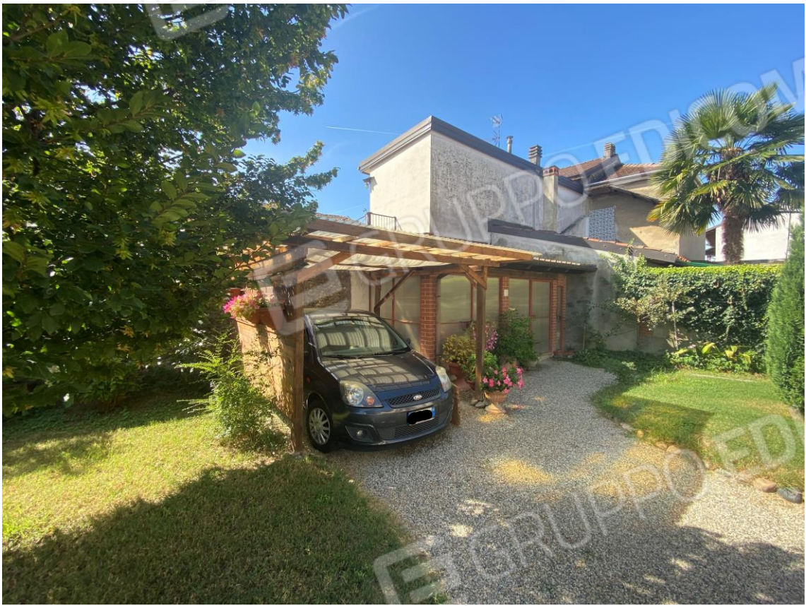
FOTO 19 : VISTA ESTERNA PORTICATO E TETTOIA
