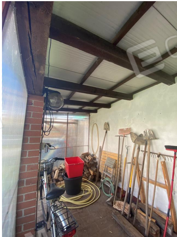
FOTO 18 : VISTA INTERNA PORTICATO PIANO TERRENO
