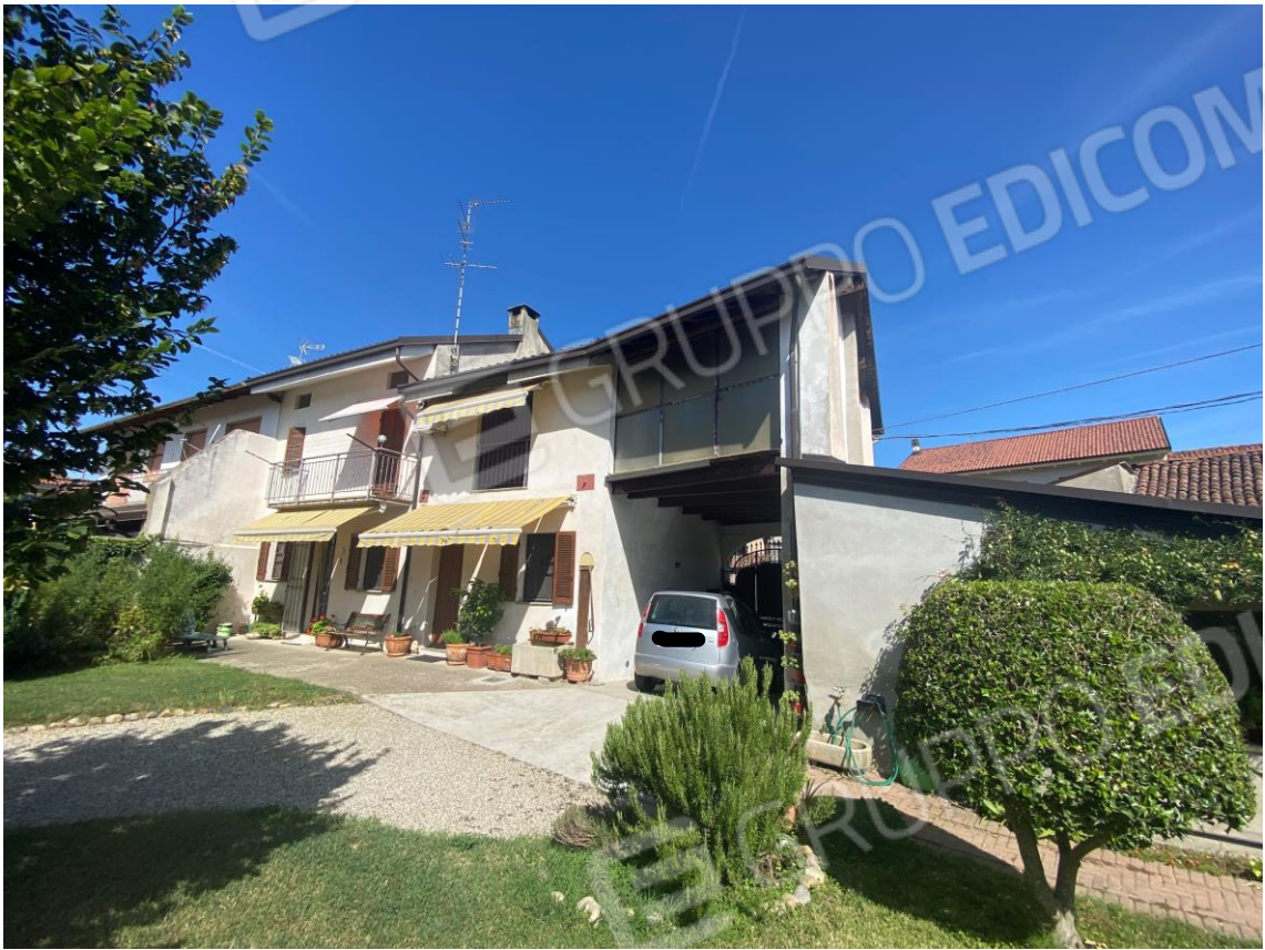
FOTO 21 : VISTA ESTERNA DELL'ABITAZIONE LATO CORTILE
