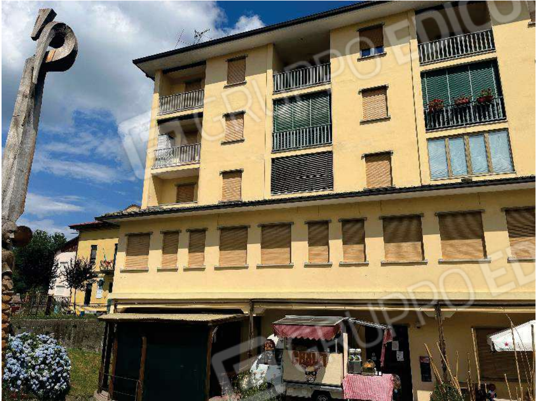
Figura 8: vista della facciata principale del fabbricato e dell'alloggio
