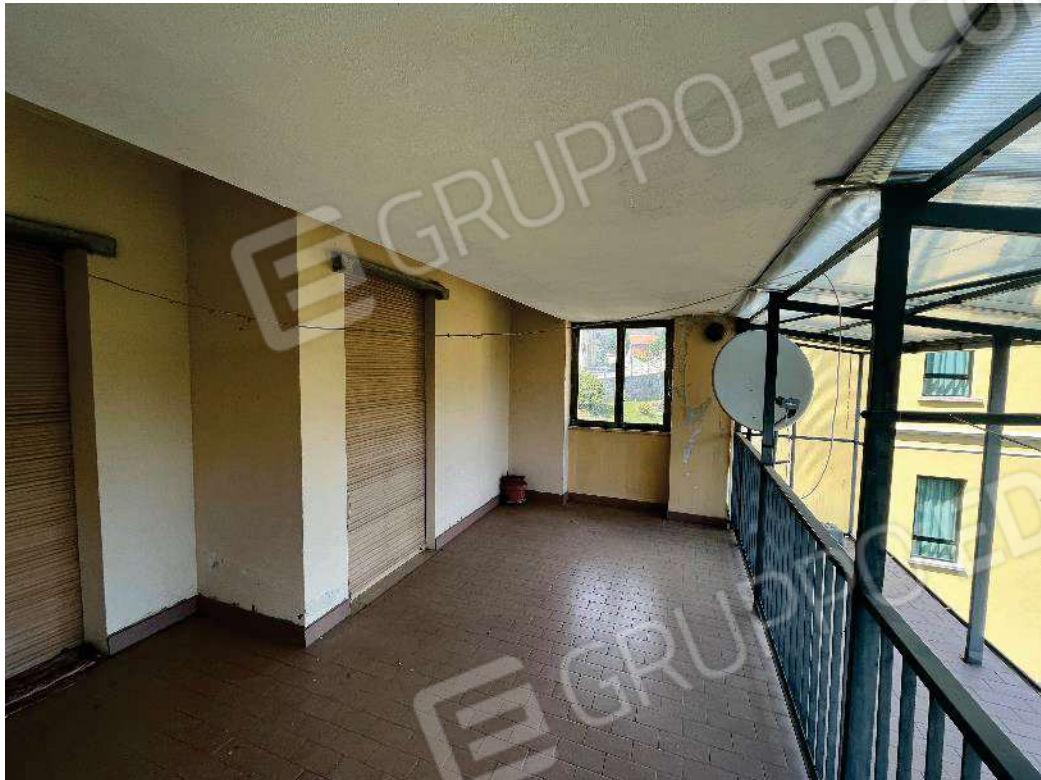
Figura 14: vista del ballatoio comune e del balcone coperto
