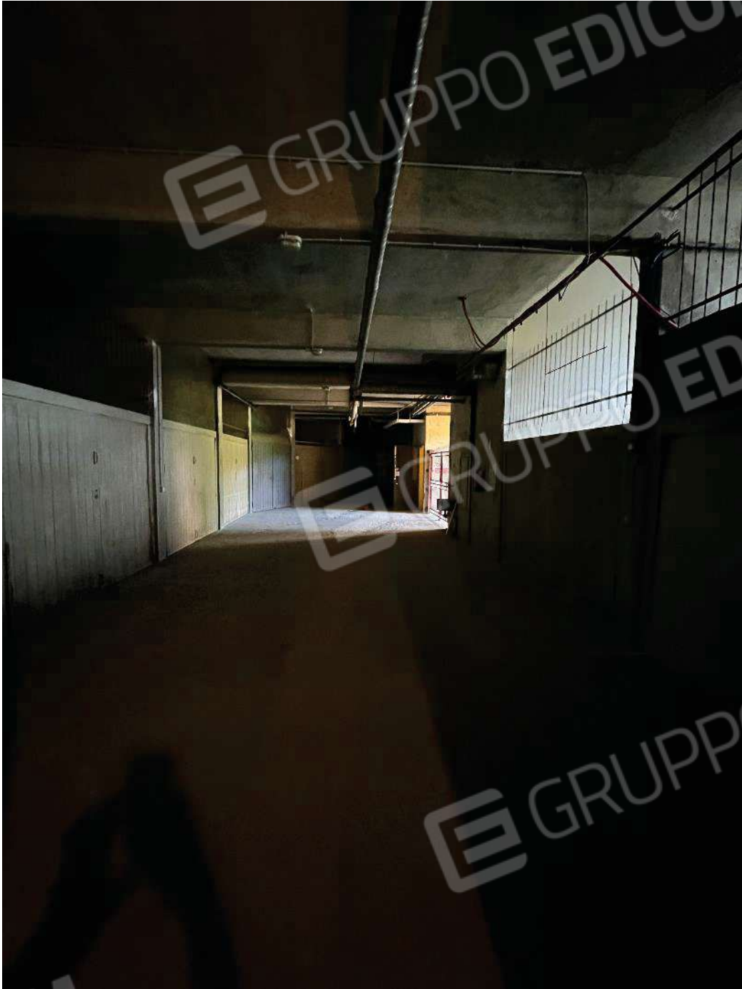
Figura 35: vista del corsello al piano primo interrato
