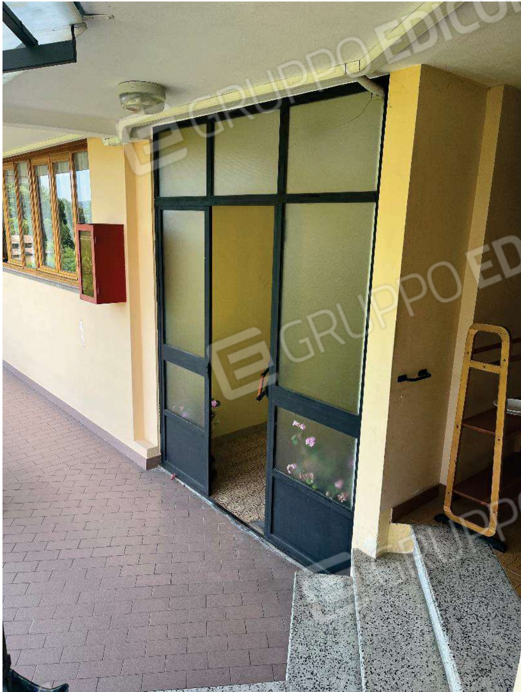
Figura 11: vista dell'accesso al ballatoio comune
