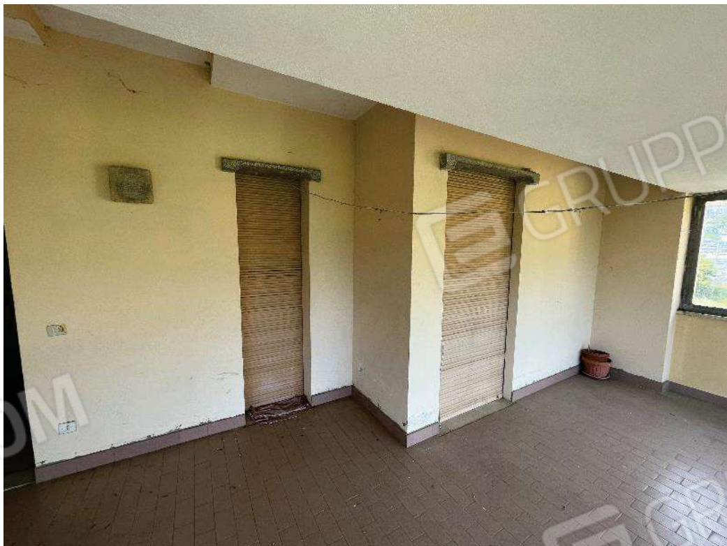
Figura 15: vista del balcone coperto
