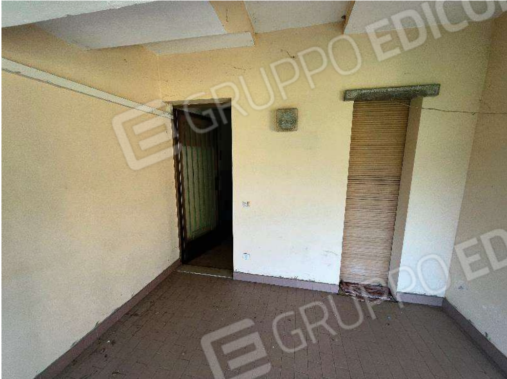
Figura 18: vista dell'ingresso dell'alloggio
