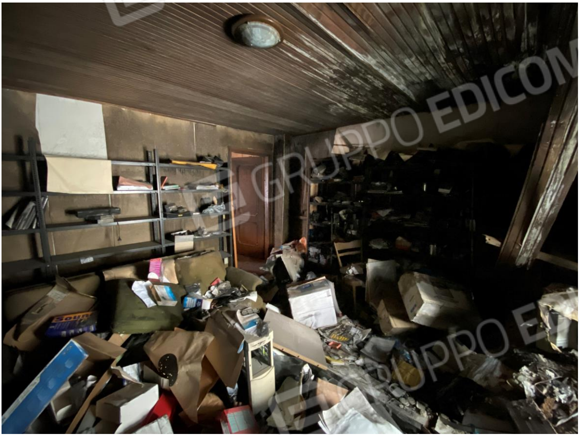
FOTO 23 : VISTA D'INSIEME CAMERA AL PIANO SECONDO
