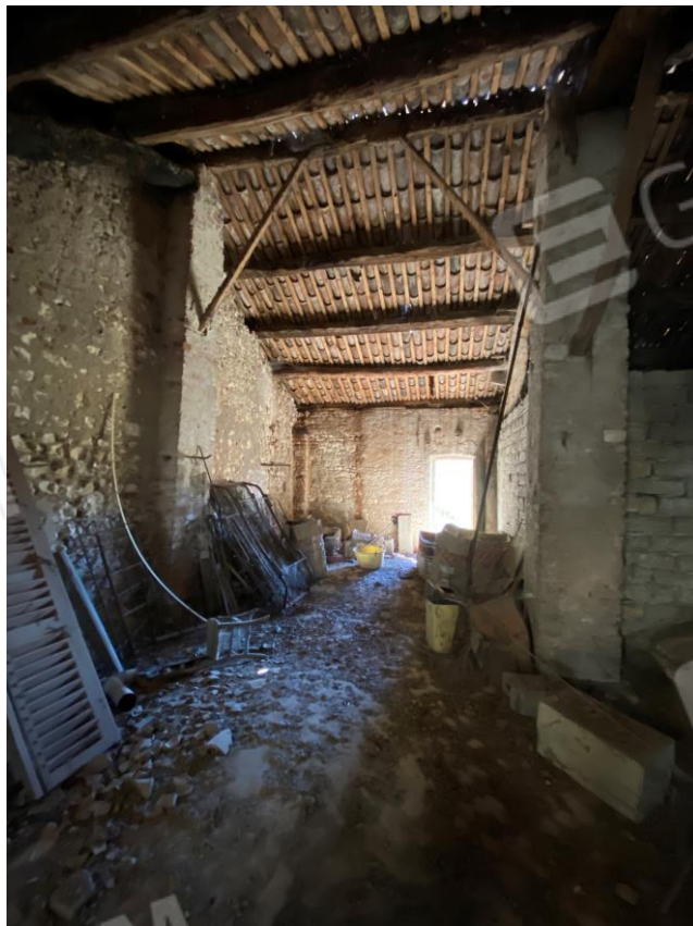
FOTO 28 : VISTA D'INSIEME EX FIENILE AL PIANO SECONDO
