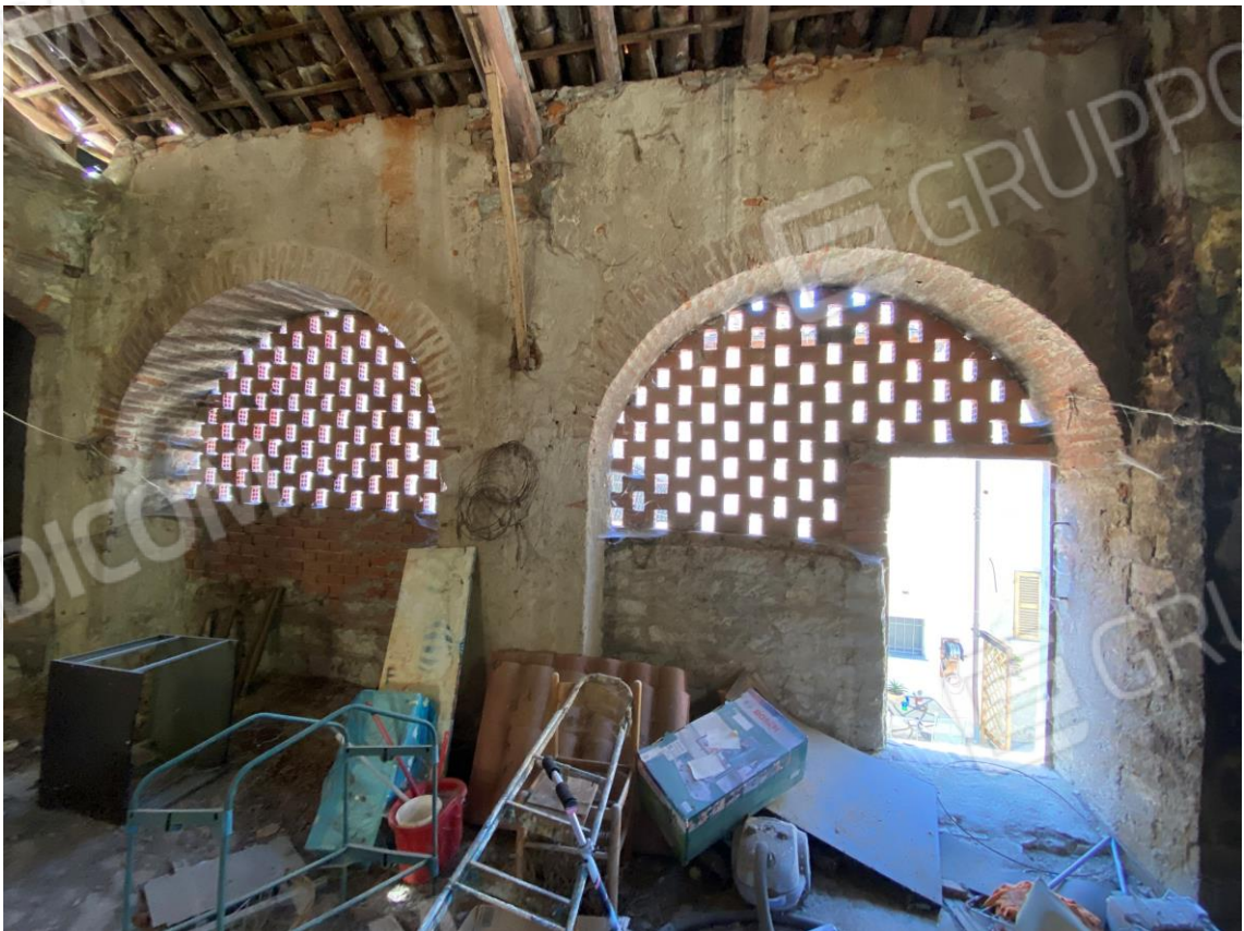
FOTO 28 : VISTA D'INSIEME EX FIENILE AL PIANO SECONDO
