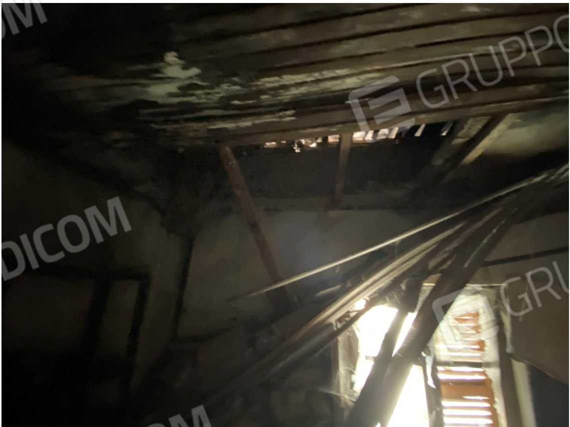
FOTO 22 : SOFFITTO CAMERA AL PIANO SECONDO
