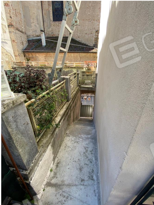
FOTO 34 : SCALA D'ACCESSO AL CORTILE ESCLUSIVO
