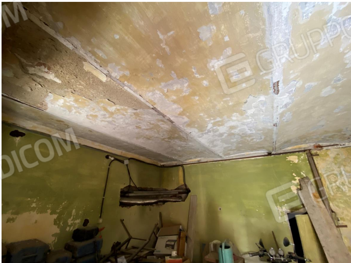
FOTO 4 : VISTA D'INSIEME LOCALE MAGAZZINO
