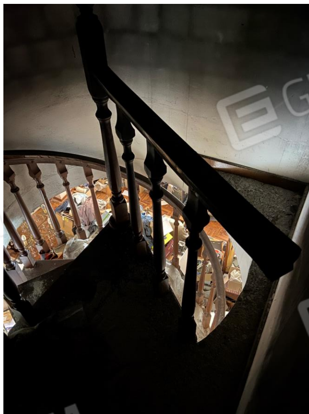
FOTO 18 : SCALA DI ACCESSO INTERNA AL PIANO PRIMO
