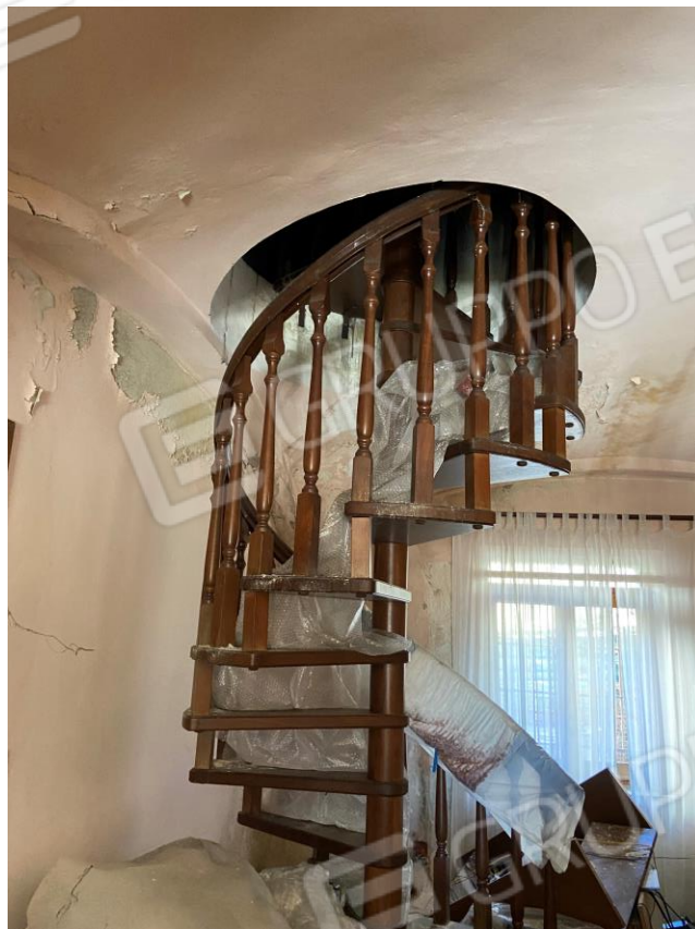
FOTO 17 : SCALA DI ACCESSO INTERNA AL PIANO PRIMO
