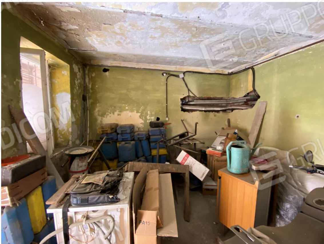
FOTO 2 : VISTA D'INSIEME LOCALE MAGAZZINO
