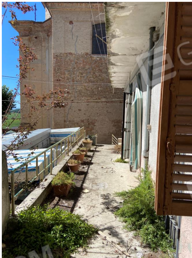
FOTO 26 : VISTA D'INSIEME BALCONE AL PIANO SECONDO
