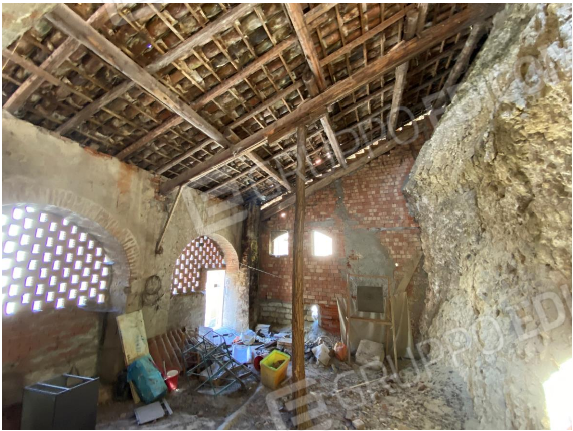
FOTO 27 : VISTA D'INSIEME EX FIENILE AL PIANO SECONDO
