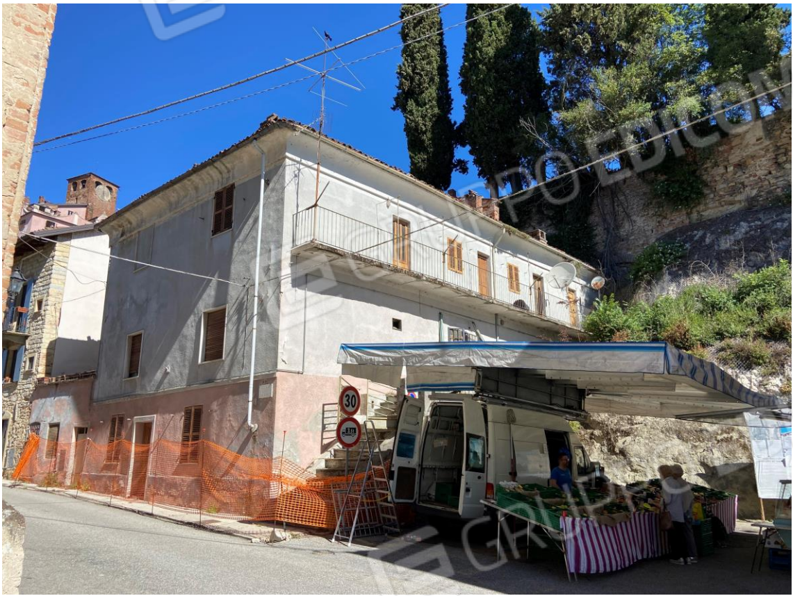
FOTO 31 : VISTA ESTERNA DEL FABBRICATO PROSPETTO EST
