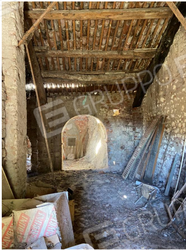
FOTO 27 : VISTA D'INSIEME EX FIENILE AL PIANO SECONDO
