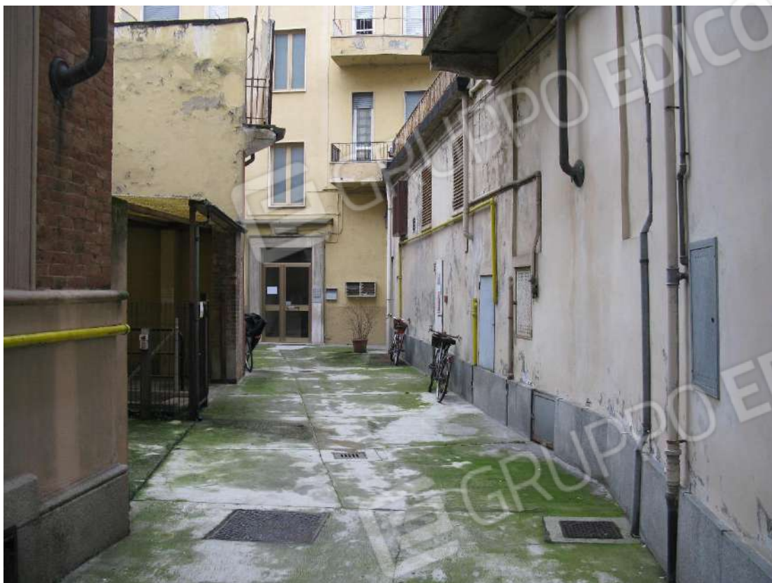
Foto 3 – Ingresso da vicolo
