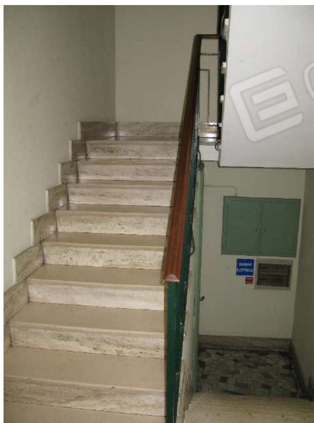
Foto 6 – Vano scala condominiale
