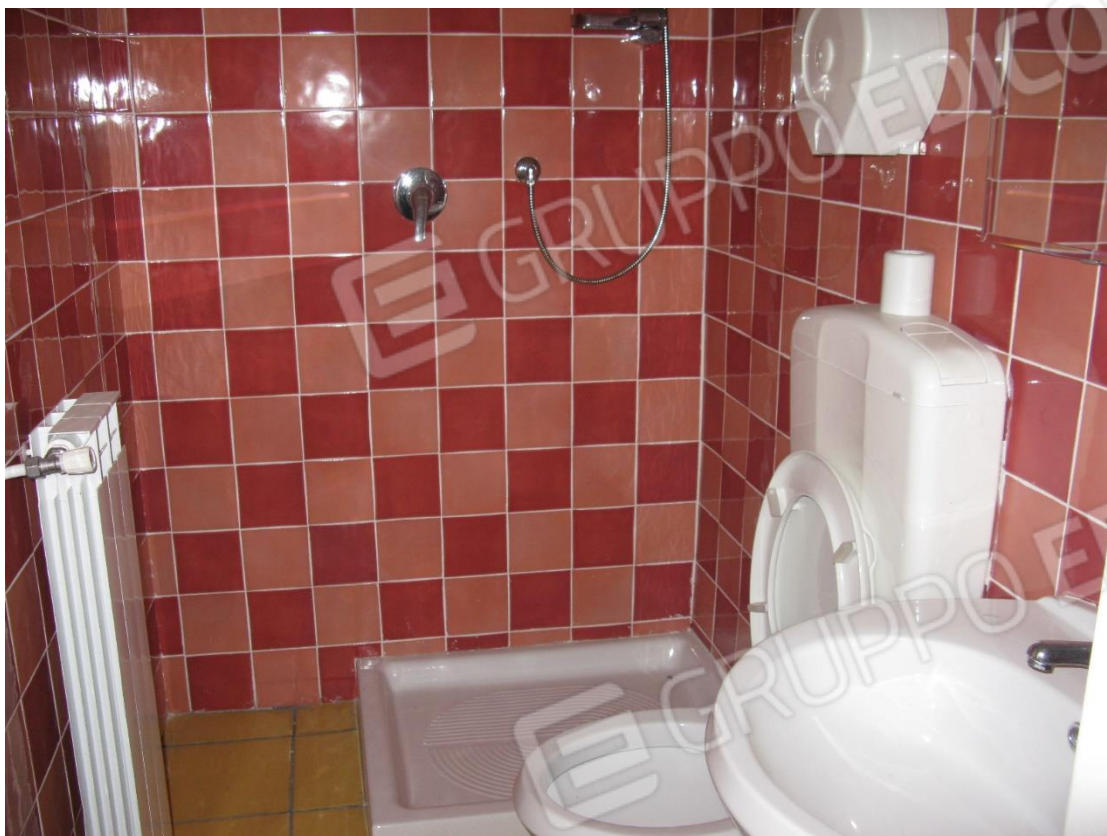
Foto 31 – Bagno terza camera al piano primo
