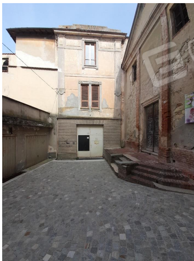
Foto 2 – Ingresso principale da Via Aldo Bergamaschino n.23
