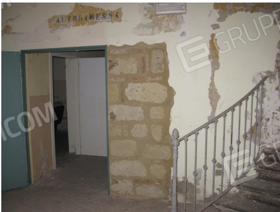
Foto 10 – Ingresso ufficio segreteria piano terreno
