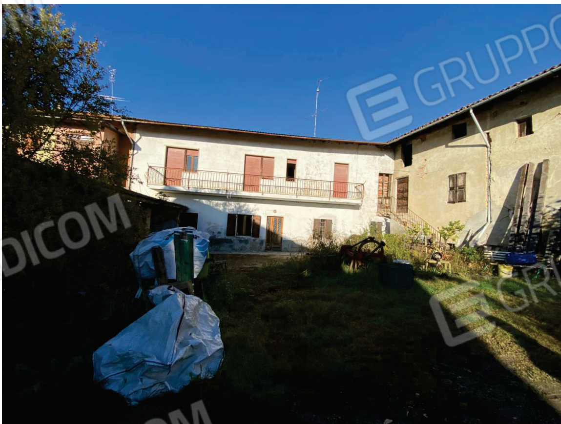
FOTO 2 : VISTA ESTERNA LATO CORTILE INTERNO
