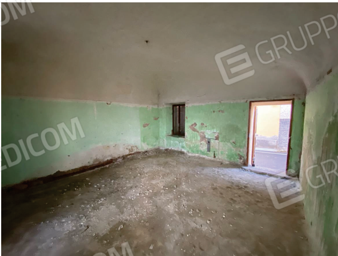
FOTO 4 : VISTA INTERNA SOGGIORNO PIANO TERRENO
