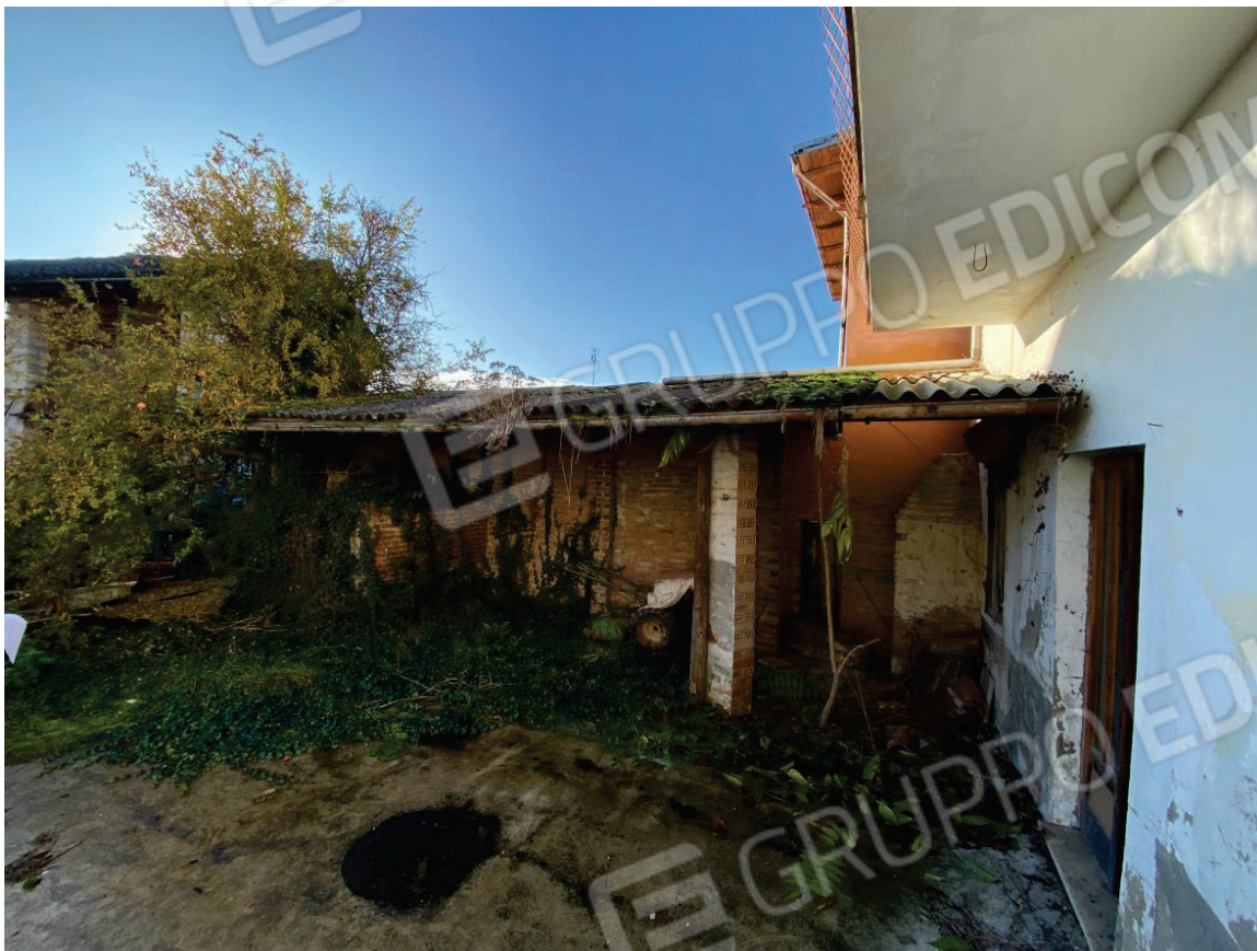
FOTO 3 : VISTA ESTERNA PORTICATO LATO CORTILE
