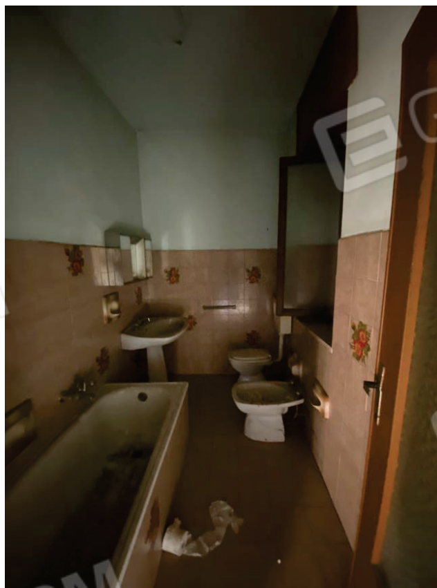
FOTO 12 : VISTA INTERNA BAGNO PIANO PRIMO
