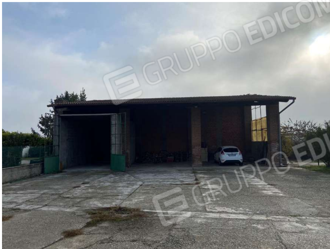
FOTO 1 : VISTA D'INSIEME ESTERNA MAGAZZINO E PORTICI
