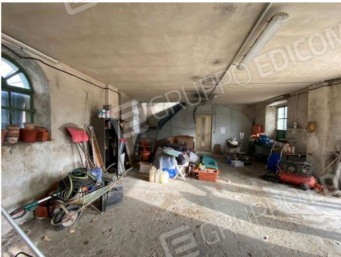
FOTO 7 : VISTA D'INSIEME INTERNA MAGAZZINO-DEPOSITO E TETTOIA
