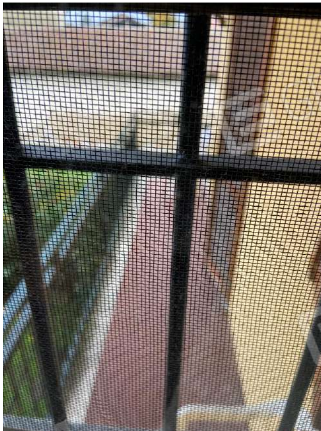
FOTO 27 : VISTA D'INSIEME ESTERNA PIANO PRIMO BALCONE
