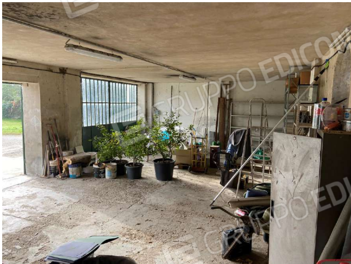
FOTO 5 : VISTA D'INSIEME INTERNA MAGAZZINO-DEPOSITO E TETTOIA
