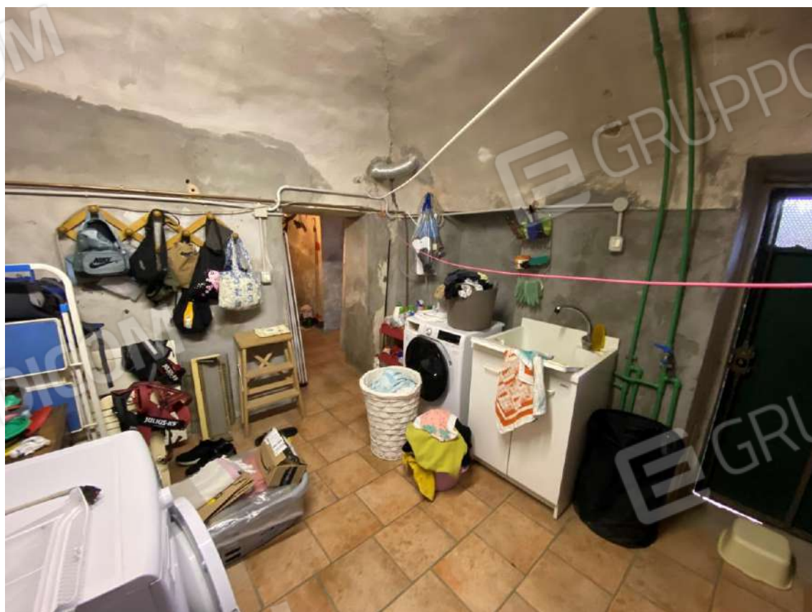
FOTO 13 : VISTA D'INSIEME INTERNA PIANO TERRENO CENTRALE TERMICA
