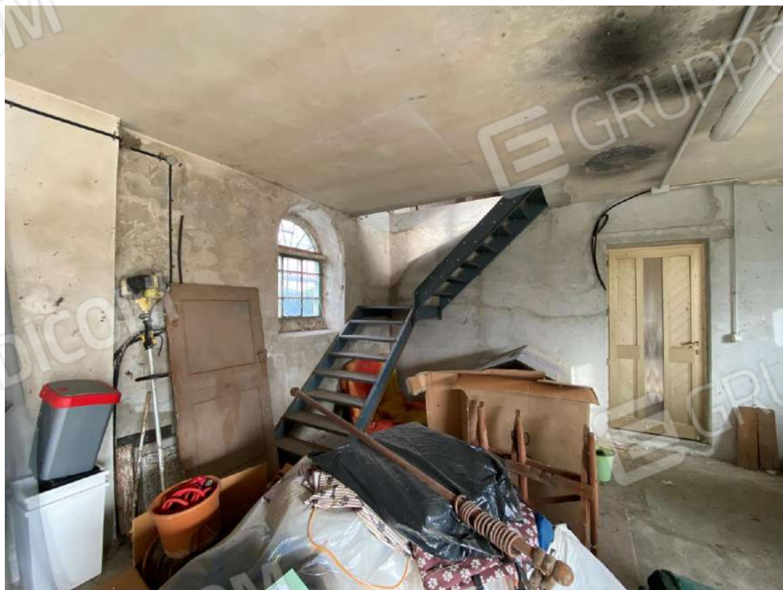
FOTO 6 : VISTA D'INSIEME INTERNA MAGAZZINO-DEPOSITO E TETTOIA
