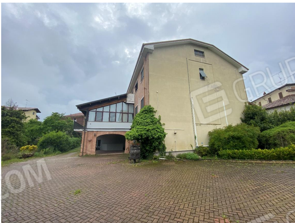
FOTO 8: VISTA LATO EDIFICIO VERSO CORTILE INTERNO
