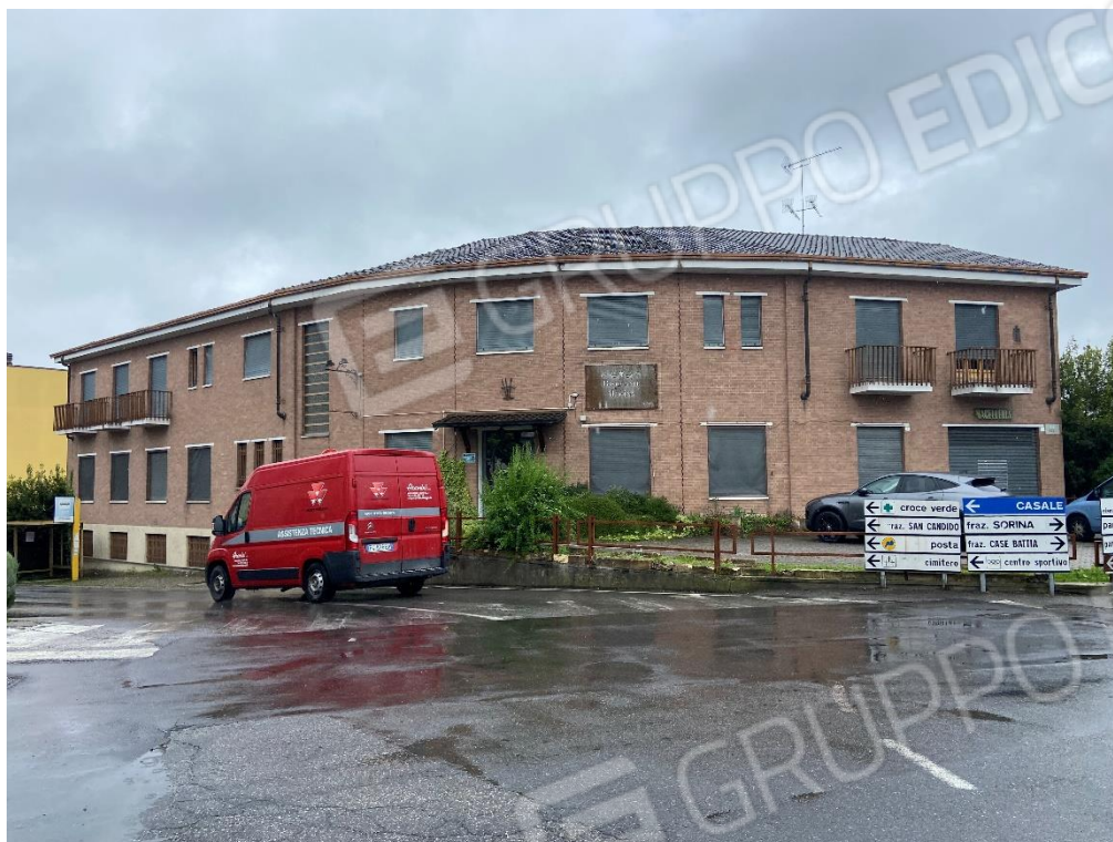
FOTO 1: VISTA FRONTALE INTERO EDIFICIO
