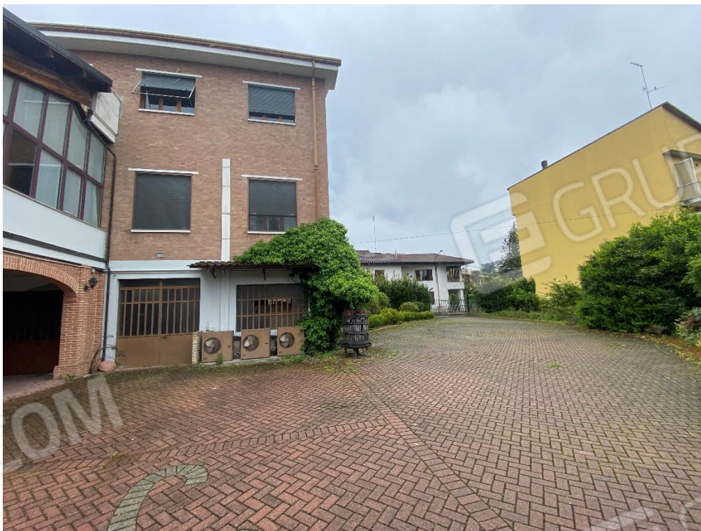
FOTO 18: VISTA ESTERNA INGRESSO GARAGE
