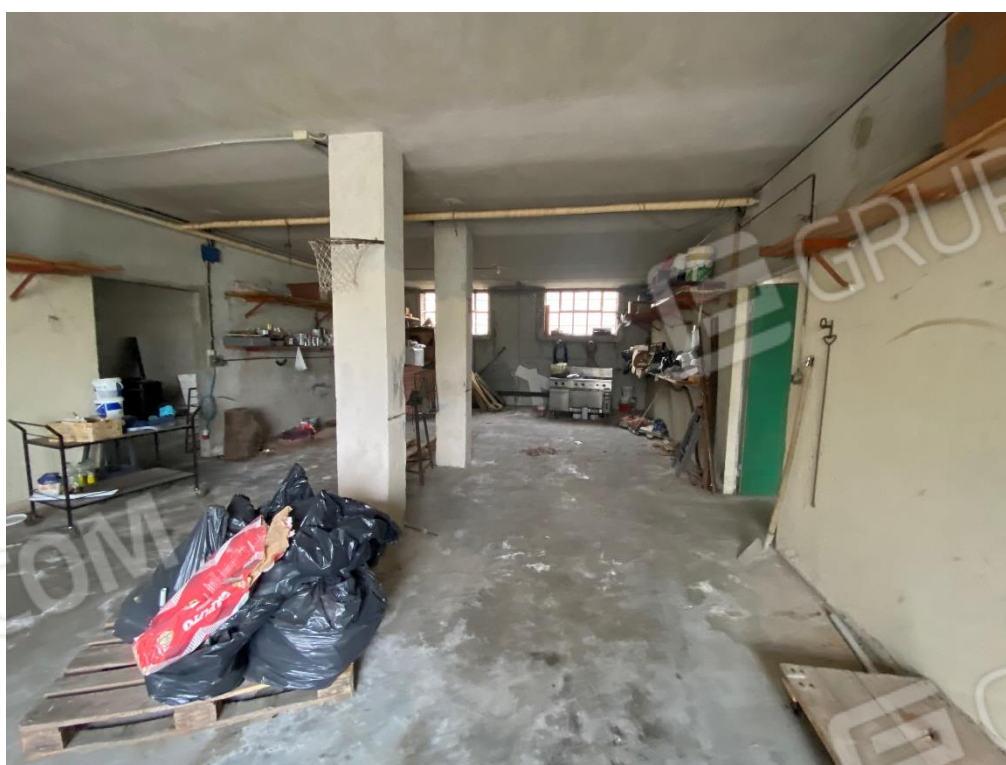
FOTO 20: VISTA INTERNA GARAGE
