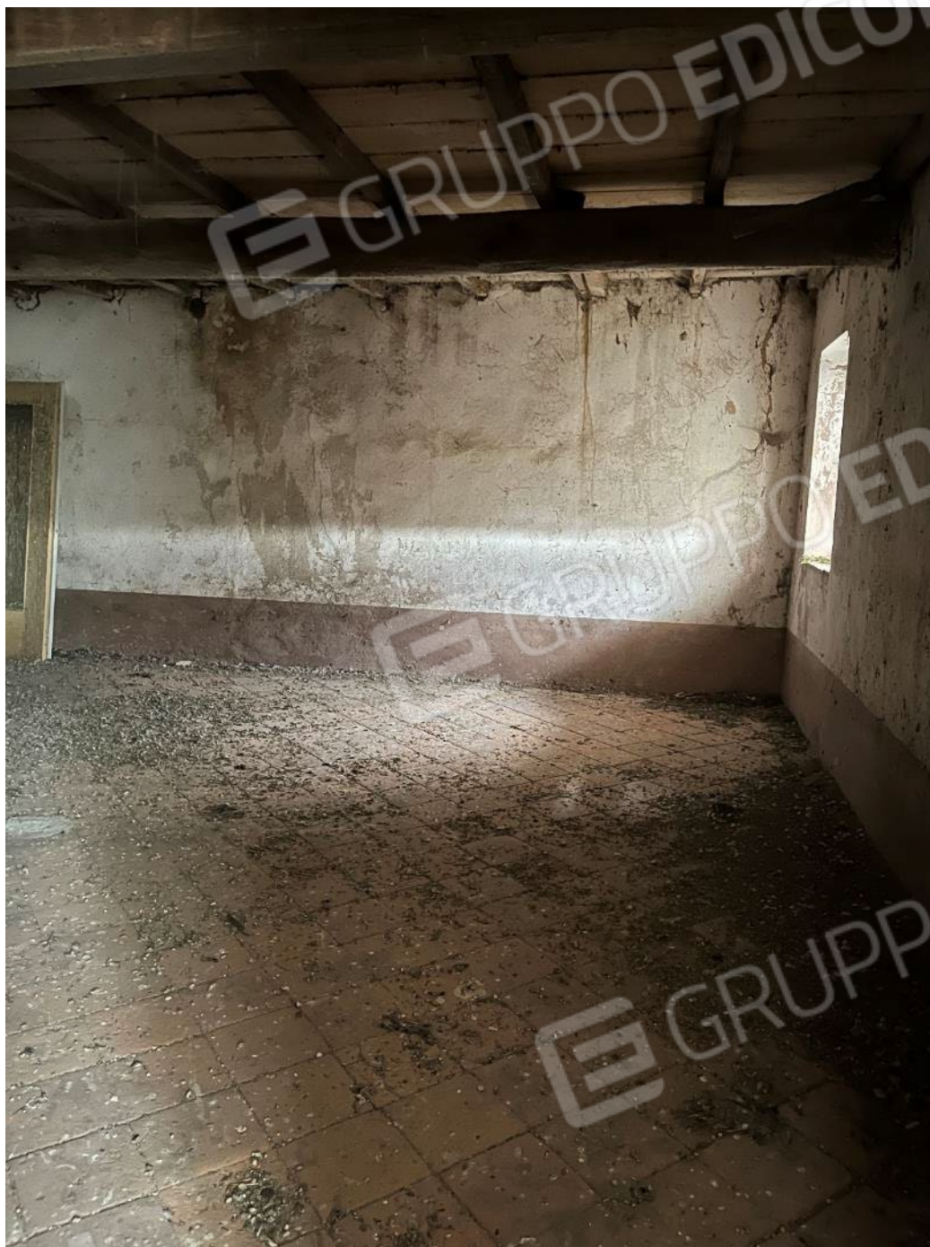
Figura 44: vista del piano primo del bene 3
