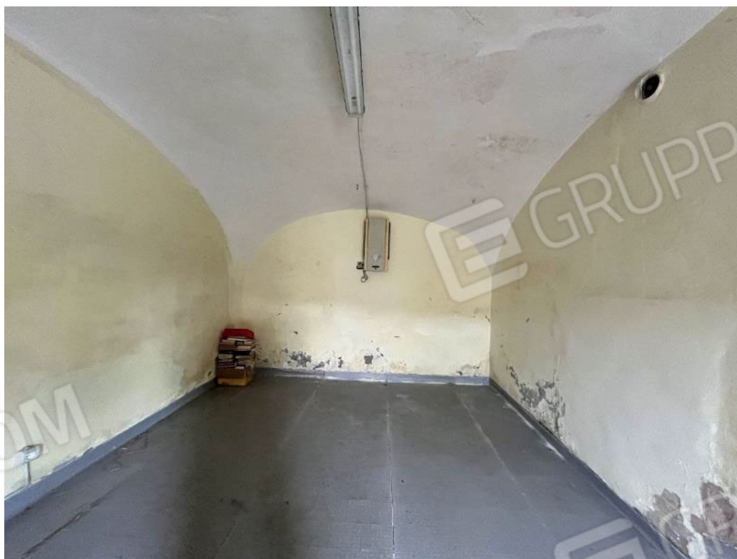
Figura 38: vista del piano terreno del bene 3
