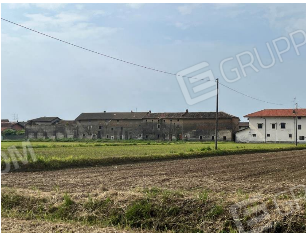
Figura 24: vista d'insieme del compendio dalla via Aosta
