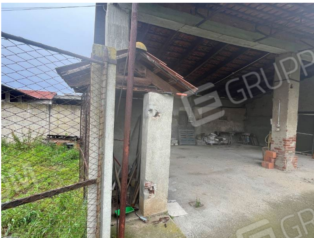
Figura 54: vista del bene 4 (seconda porzione)
