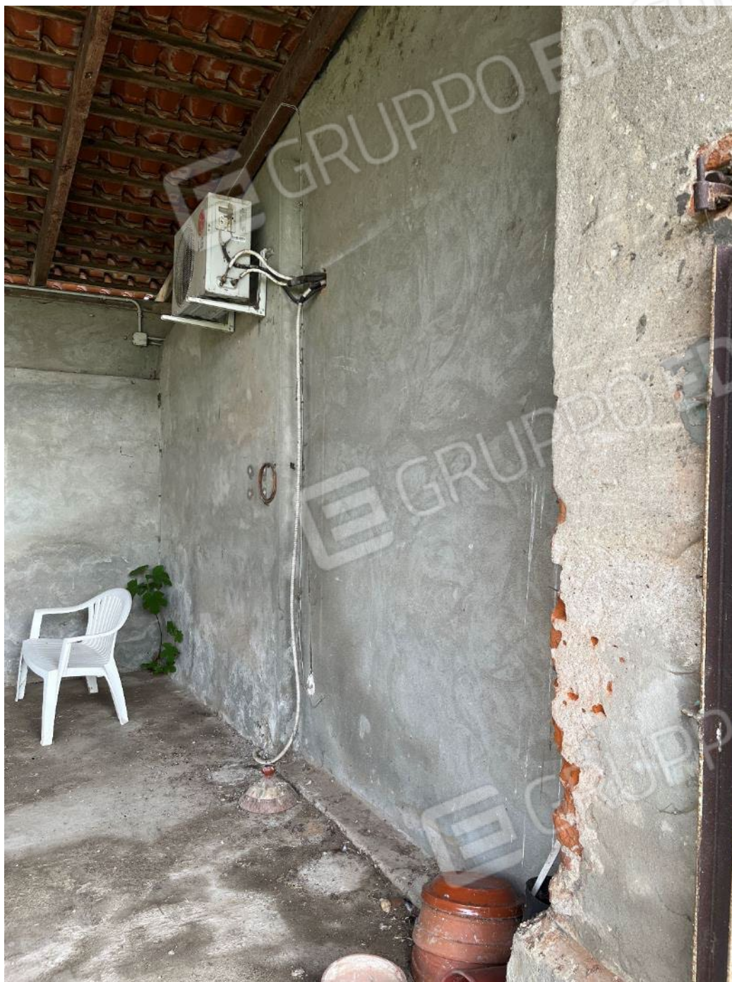
Figura 52: vista del bene 4 (seconda porzione)
