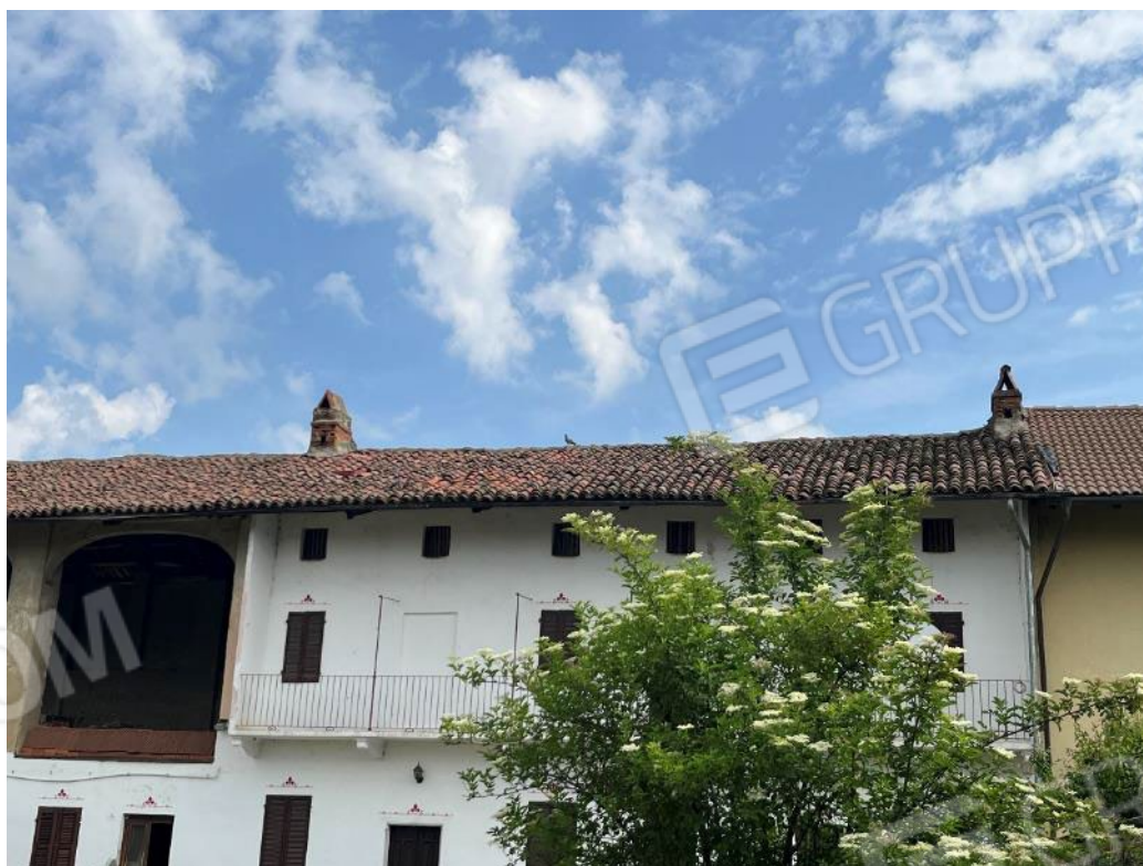
Figura 8: dettaglio del manto di copertura
