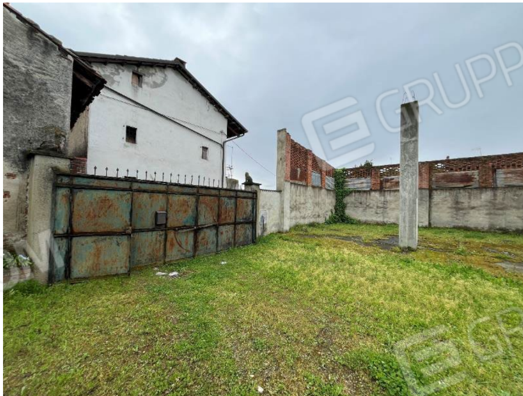
Figura 2: vista dell'accesso pedonale e carraio
