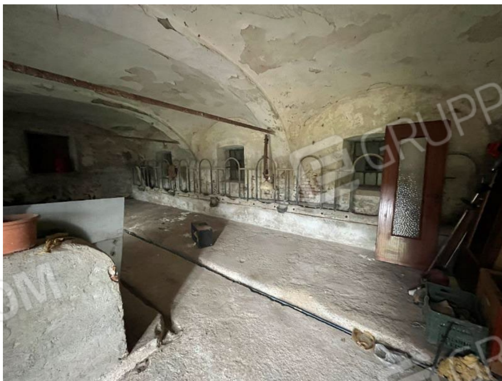
Figura 42: vista del piano terreno del bene 3
