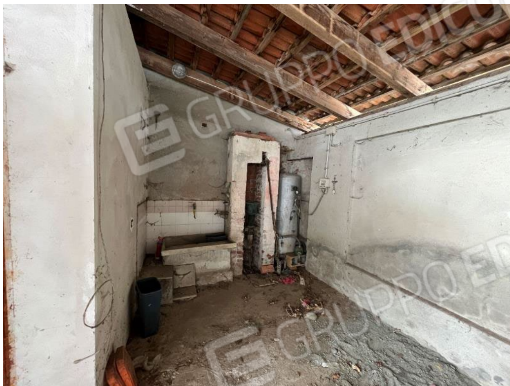
Figura 49: vista del bene 4 (prima porzione)
