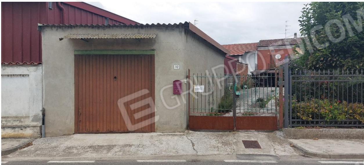
FOTO 1 – Facciata su Via Roma n.32
