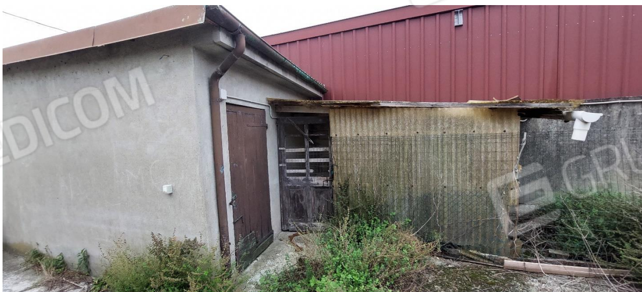
FOTO 3 – Struttura precaria addossata al garage da rimuovere
