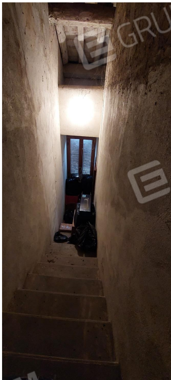
FOTO 25 – Vano scala di accesso al sottotetto
