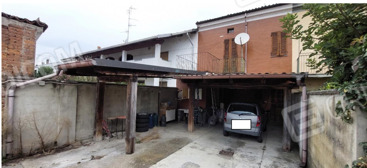
FOTO 6 – Porticati e facciata fabbricato civile
