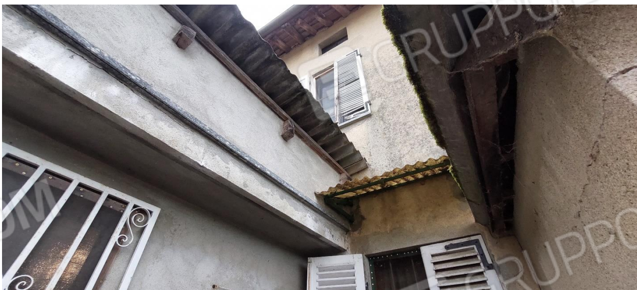
FOTO 17 – Facciata nord fabbricato
