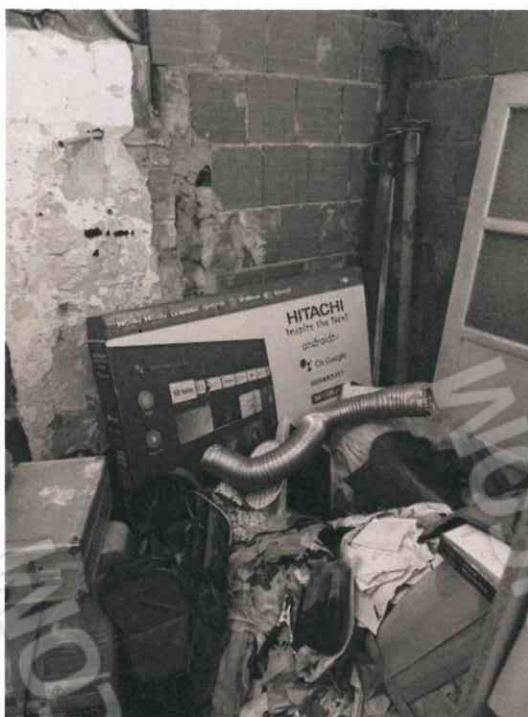
12) W.C. P.T. DA RISTRUTTURARE
