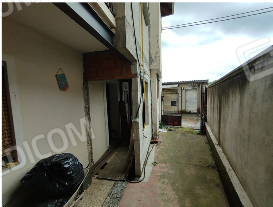
Foto 2 – vista esterna lato con ingresso
