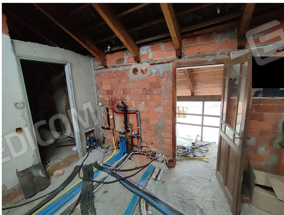
Foto 18 – piano secondo sottotetto
