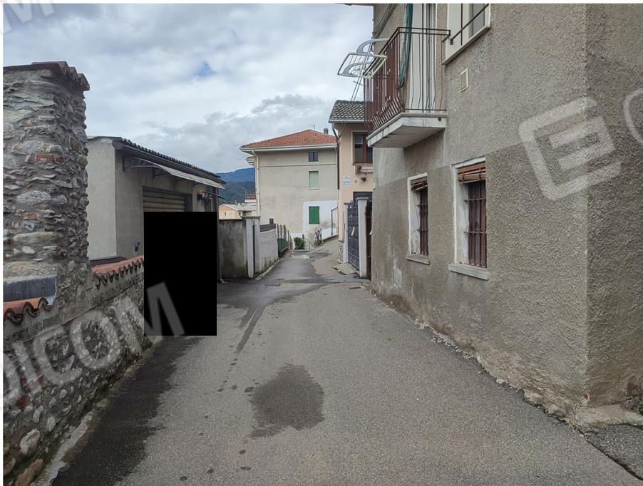
Foto 4 – vista esterna dalla strada
