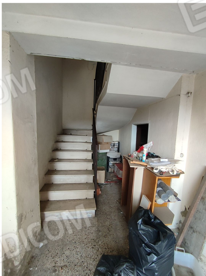
Foto 8 – piano terra vano scala
