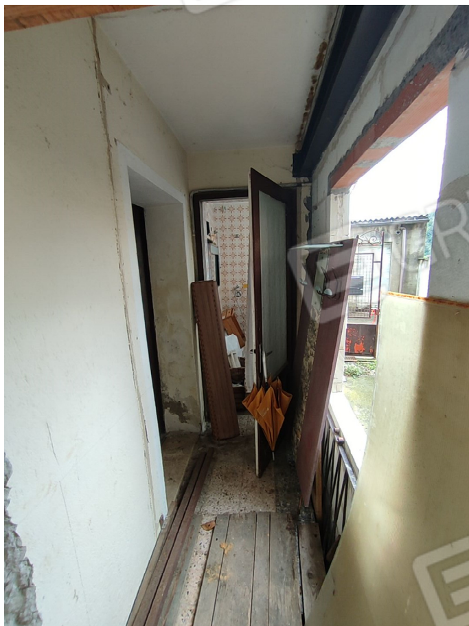
Foto 5 – piano terra disimpegno
