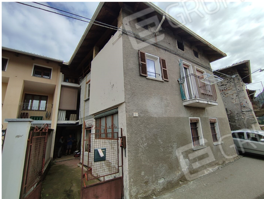
foto 1 – vista esterna lato ingresso piano terreno
