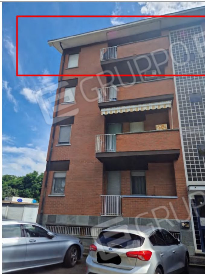
FOTO 04 facciata ingresso, individuazione unità immobiliare
