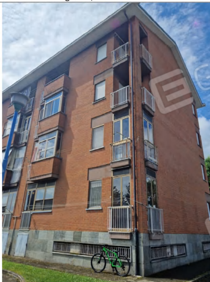
FOTO 05 facciata retro verso cortile condominiale
