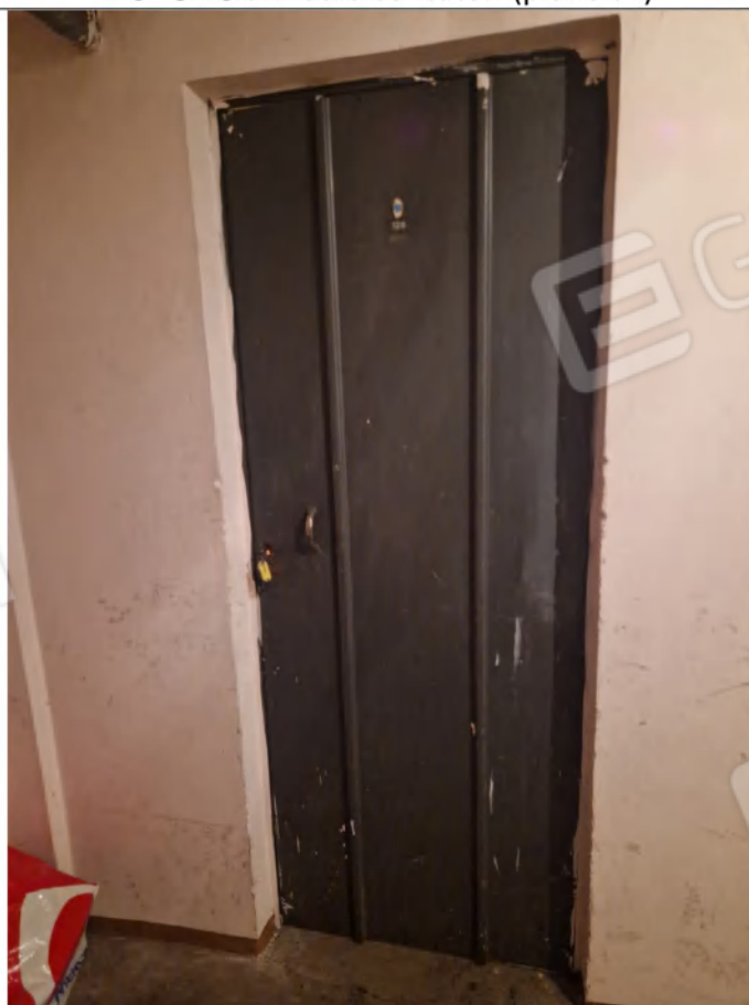
FOTO 24 porta di accesso a locale cantina
