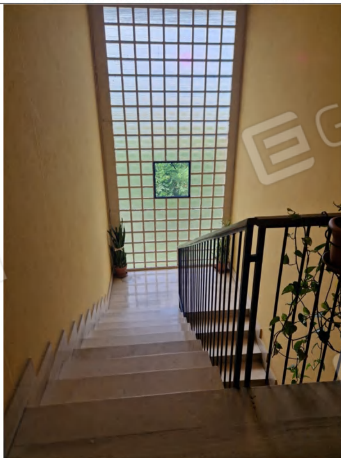
FOTO 07 vano scala condominiale piano alloggio
