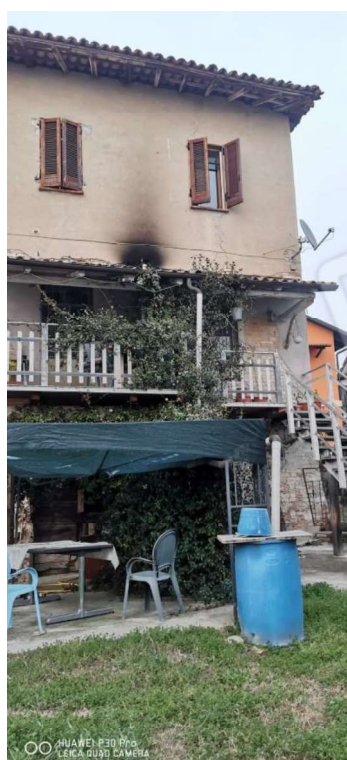
Esterno Soppalco lato soggiorno e scala esterna
