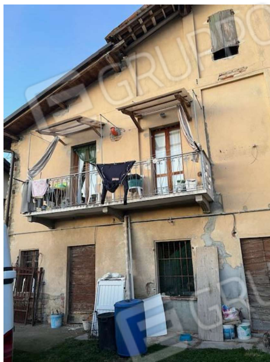
Esterno F.7 n.38 sub 3 e sub 4
