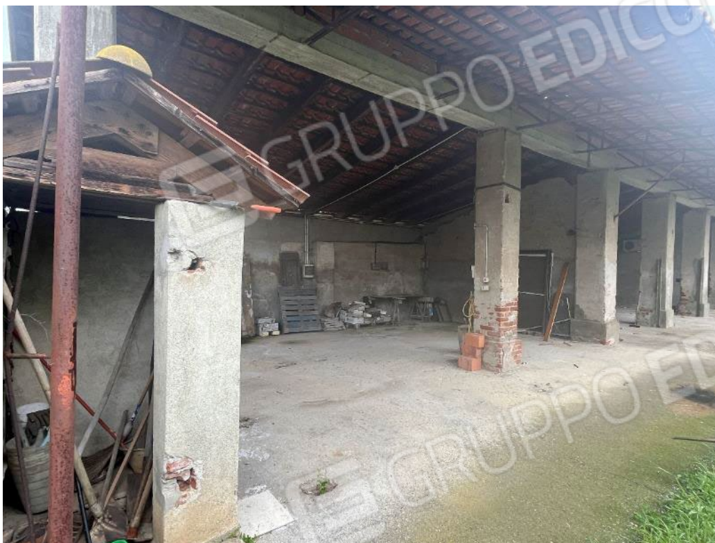
Figura 53: vista del bene 4 (seconda porzione)
