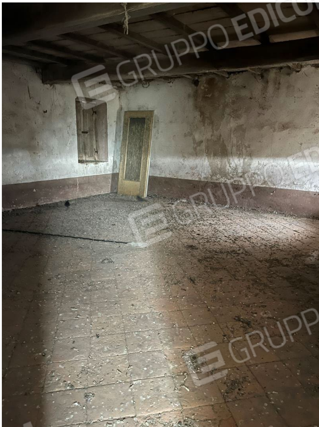
Figura 43: vista del piano primo del bene 3
