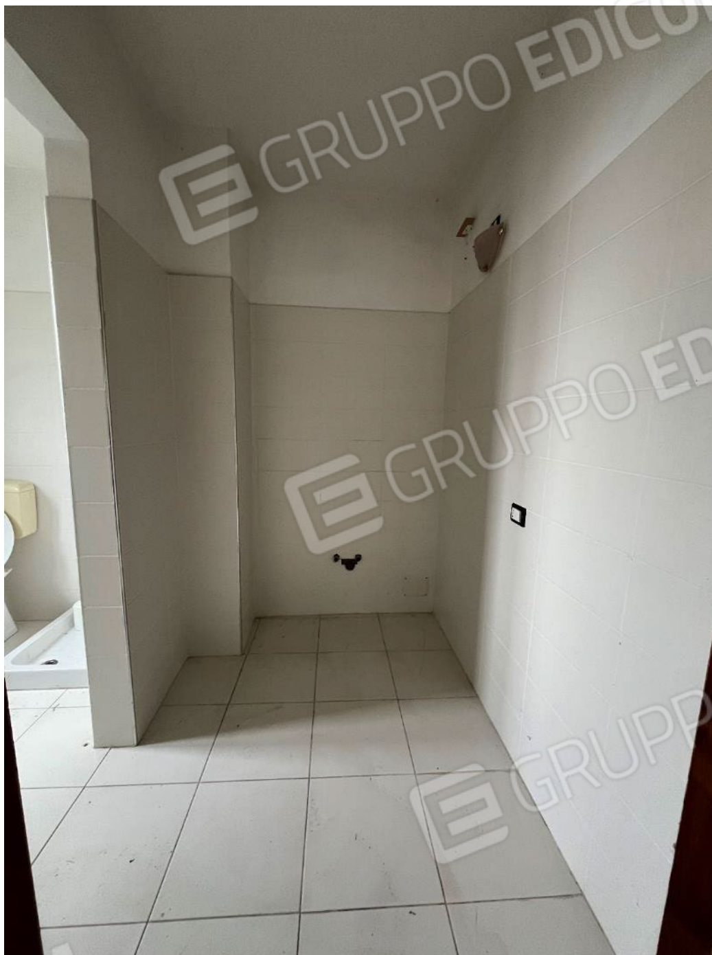
Figura 51: vista del bene 4 (prima porzione)
