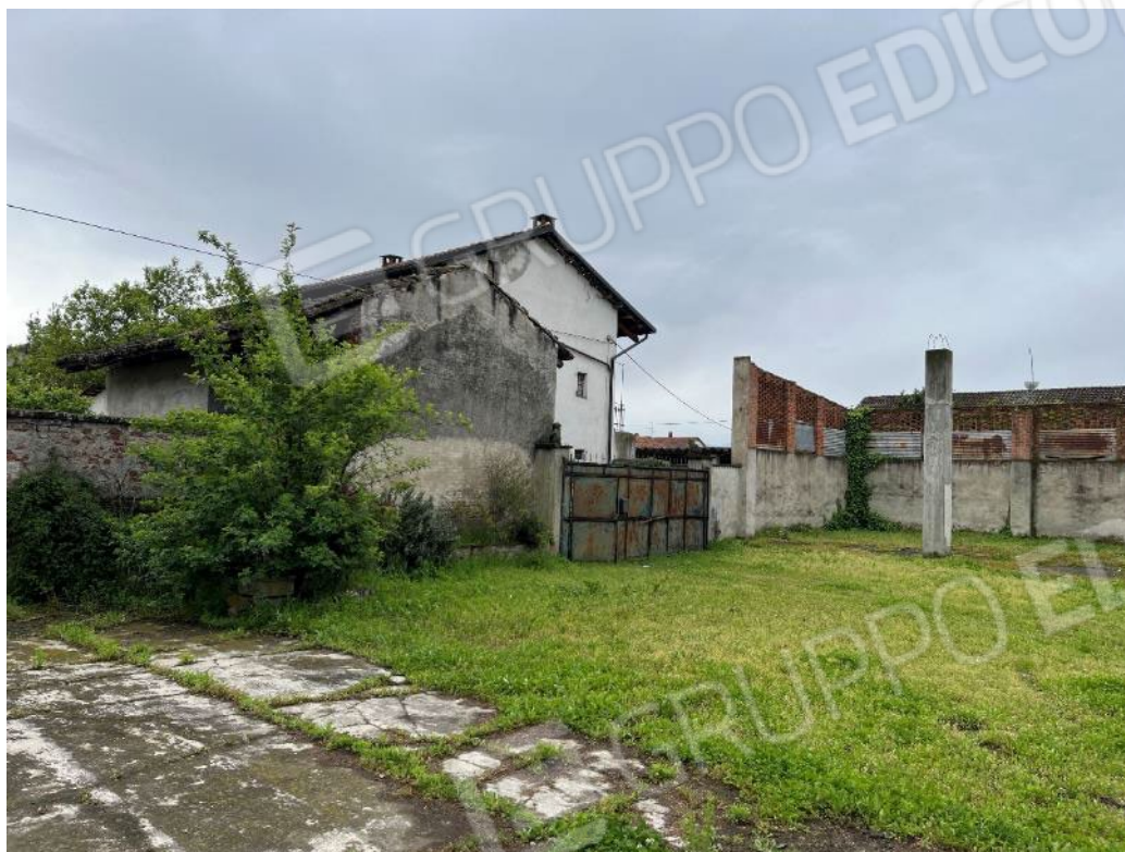
Figura 3: vista d'insieme dell'accesso pedonale e carraio
